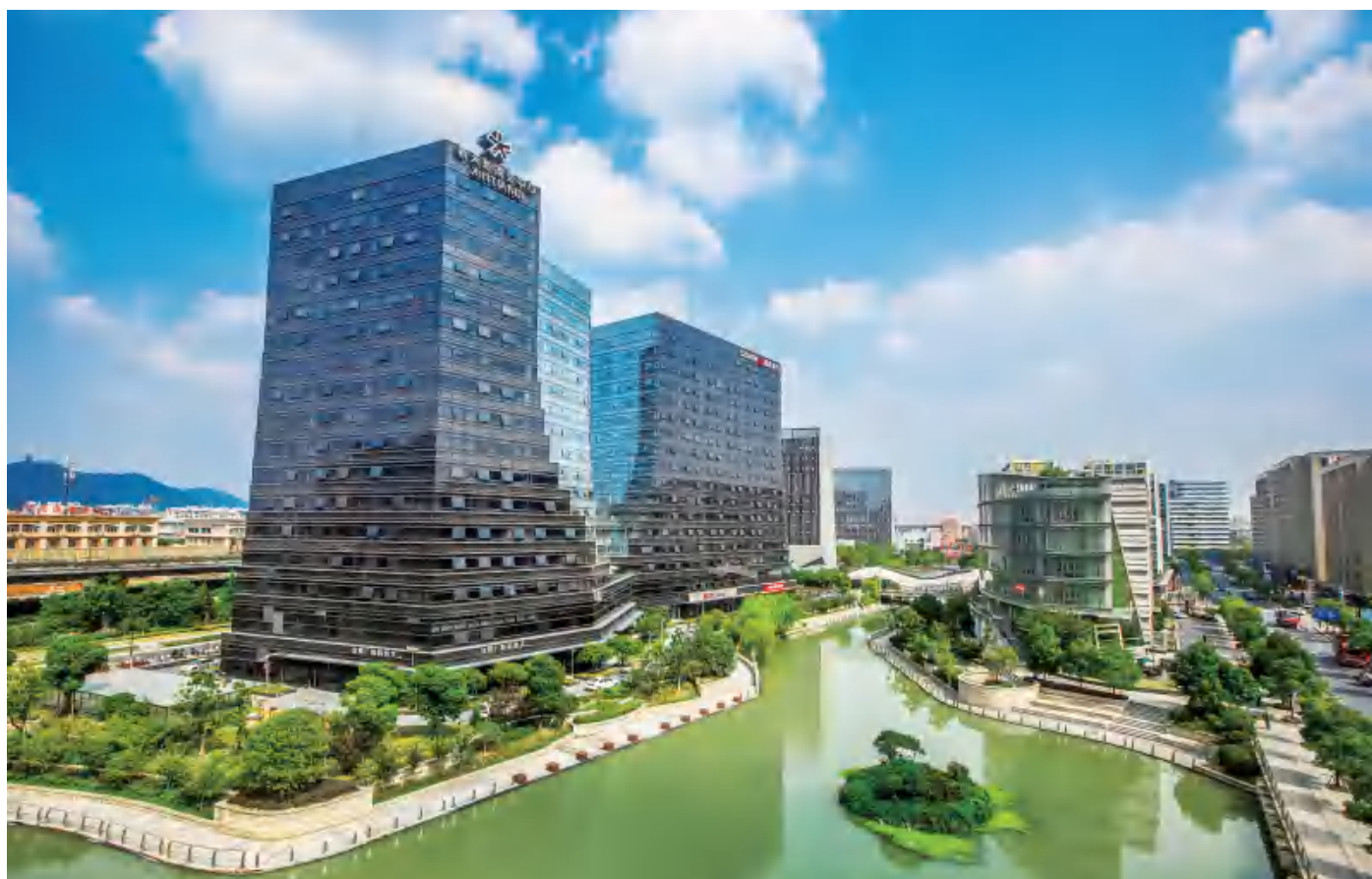
杭州新天地购物中心(摄于2021年)
