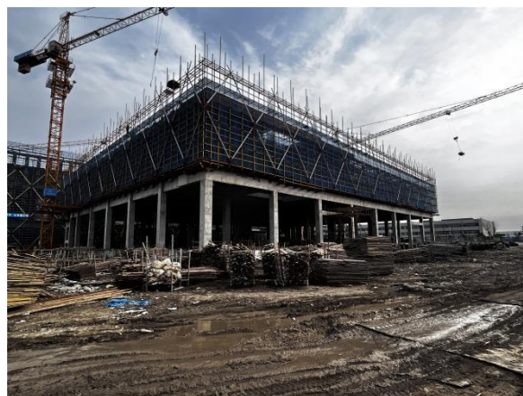
项目东南侧现状
