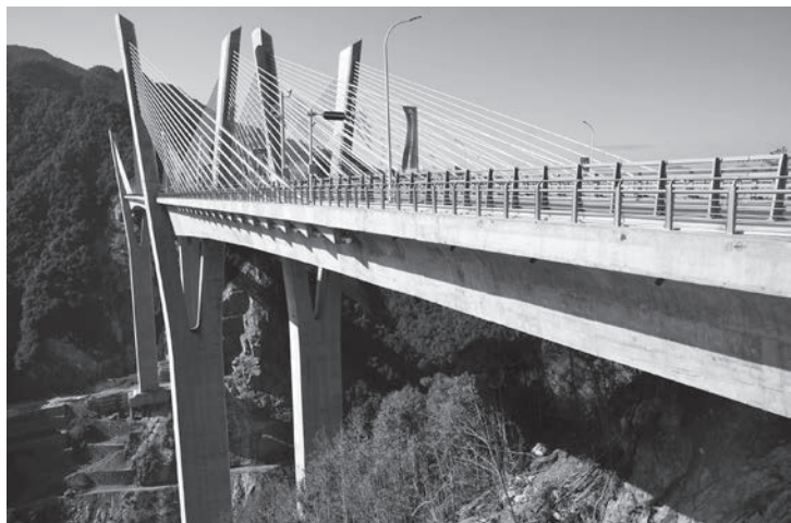
文泰高速公路 洪溪特大桥
