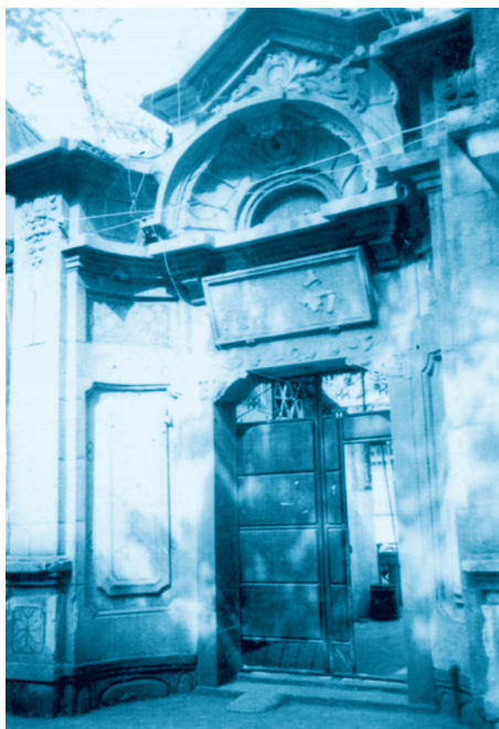
浙江省第五区干部学校旧址
