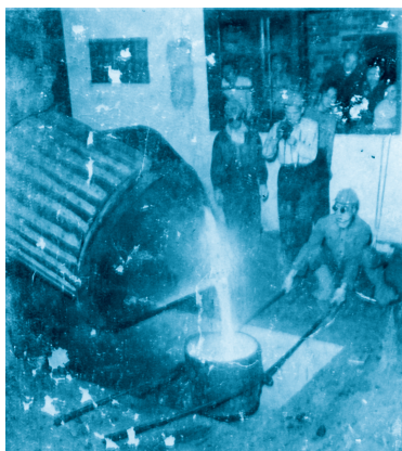
土制炼钢炉炼钢
