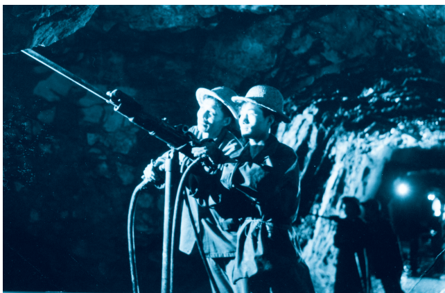
1969年9月，温州港务局职工在挖防空洞
