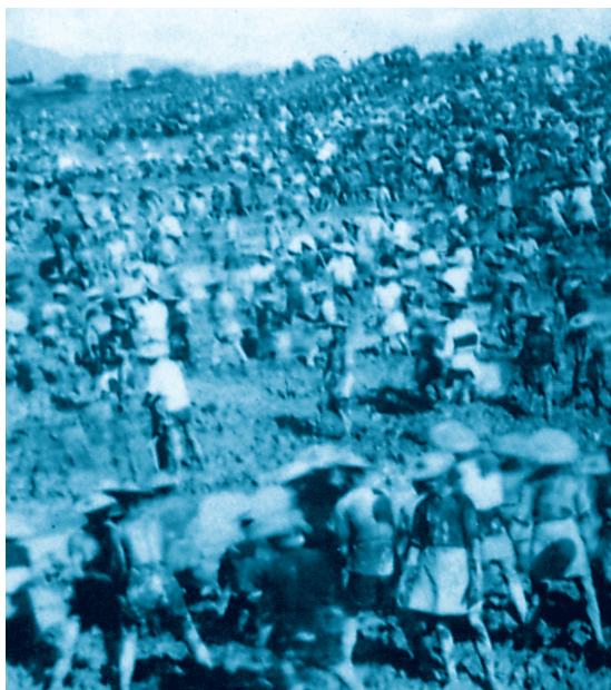
兴修水利工地现场
