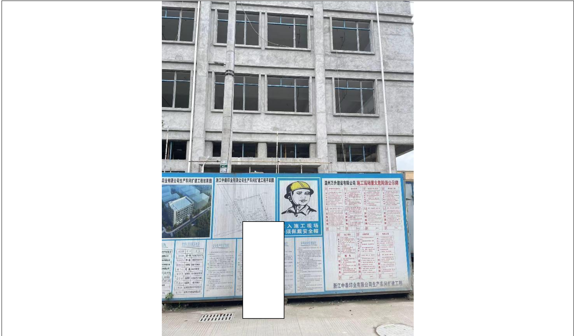
附图 14 工程师现场踏勘照片
