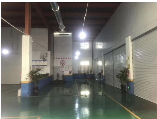
车间内地面防腐防渗措施落实到位，分区明确
