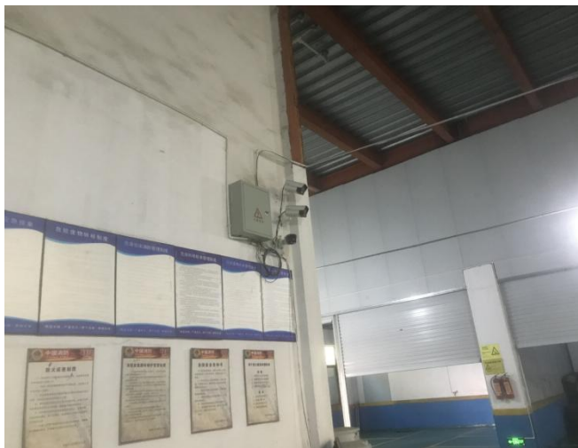
危险废物仓库内设置监控以及相关制度上墙
