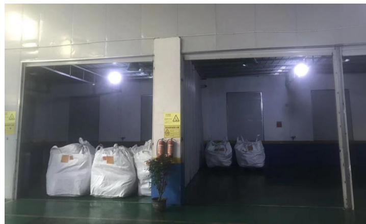
危险废物暂存间分区设置以及车间内配备消防灭火器等应急装备
