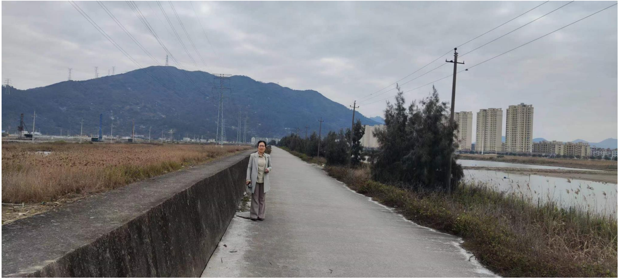
附图 1 工程师现场踏勘照片
