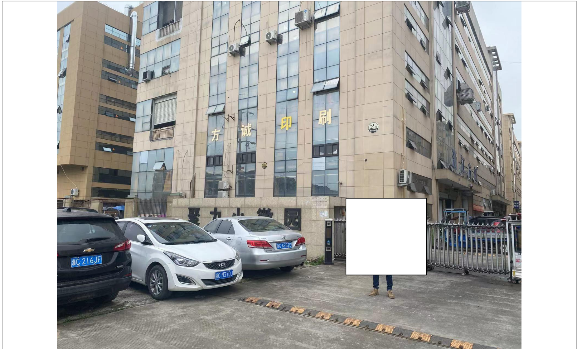
附图 1 编制主持人现场勘察照片
