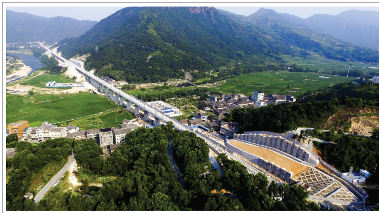
泽雅镇周岙天长特大桥
