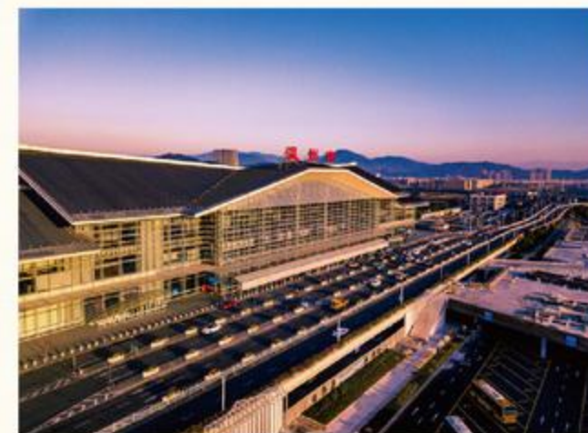
俯瞰温州动车南站。张福昆 摄
