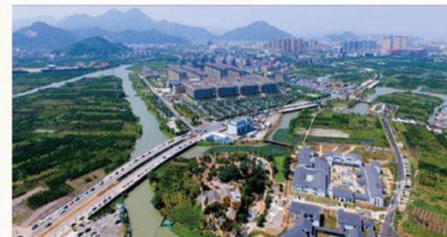
建设中的瓯海生命健康小镇。 杨冰杰 航拍
