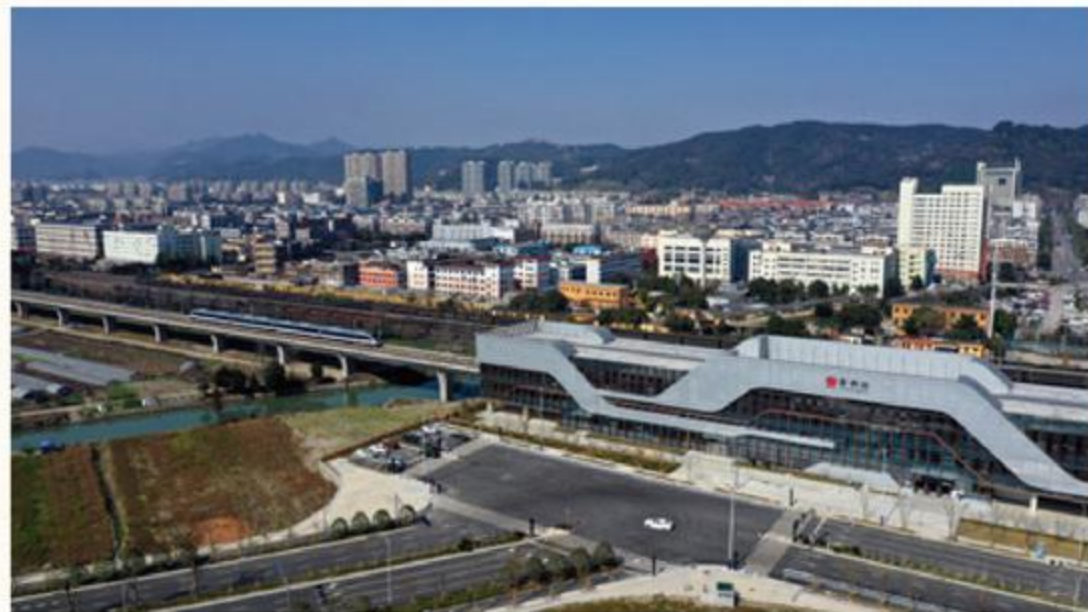
温州轨道交通S1线新桥站。郑高华 航拍
