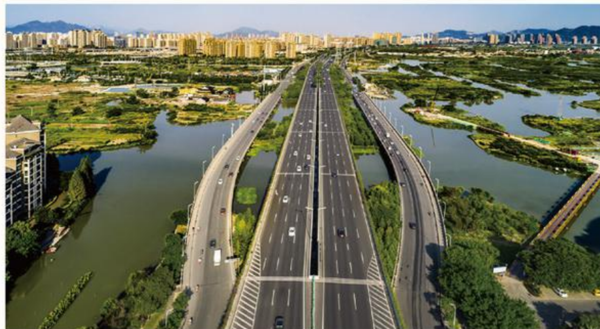
整治提升后的瓯海大道。严艳影 摄
