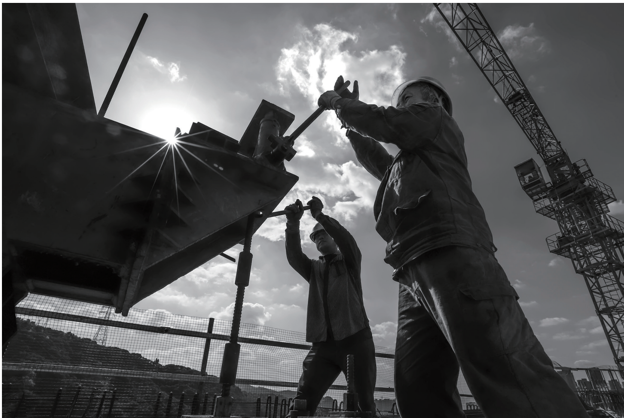
施工现场 摄 / 管新民
