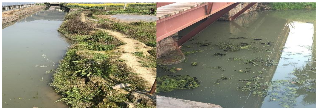
图 2.5-1 河道污染现状
