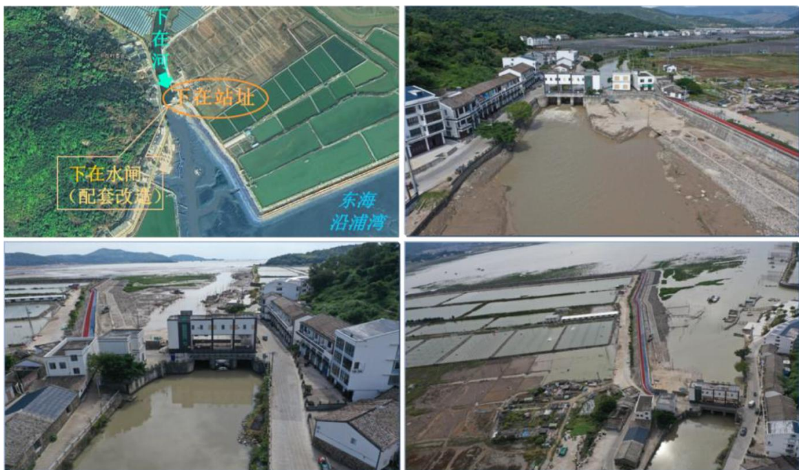
图 2.2-5 下在水闸现状
