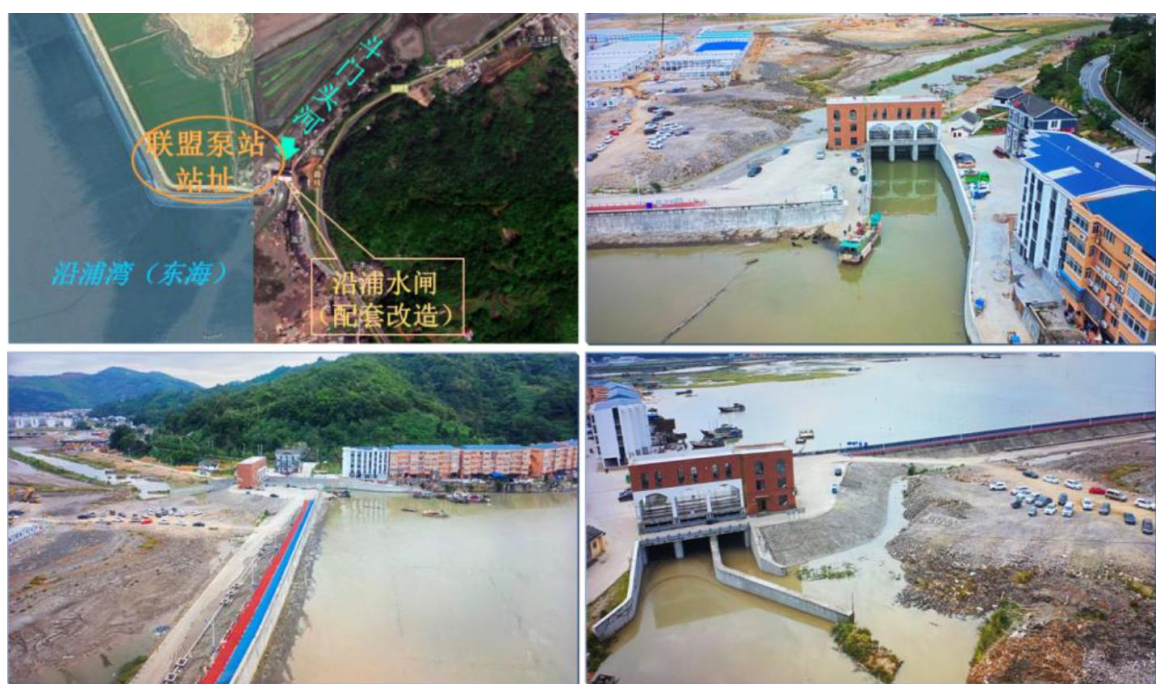
图 2.2-7 联盟水闸现状
