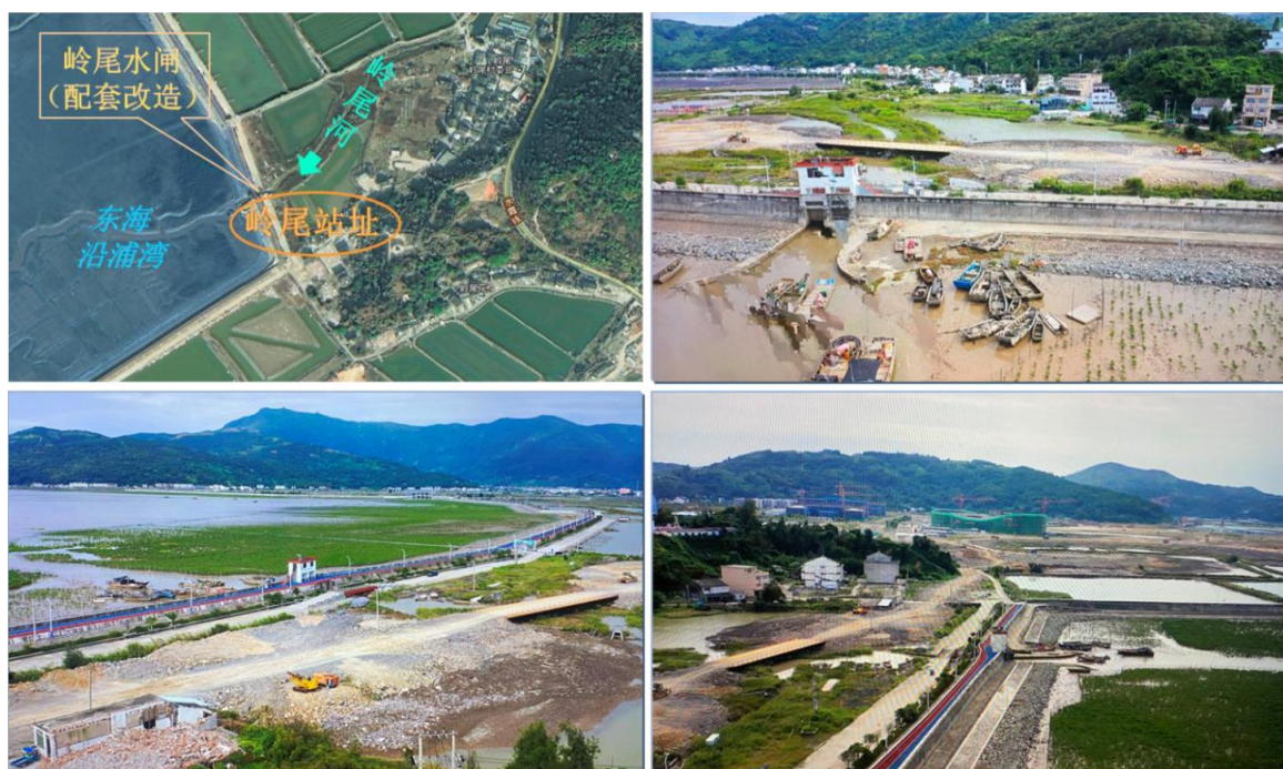
图 2.2-6 岭尾水闸现状
