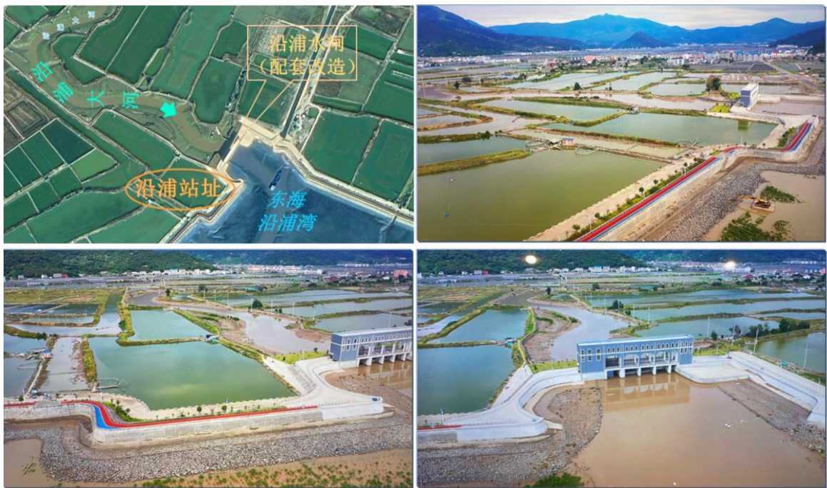
图 2.2-4 沿浦水闸现状
