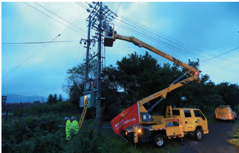
国网苍南县供电公司全力实施电力抢修
