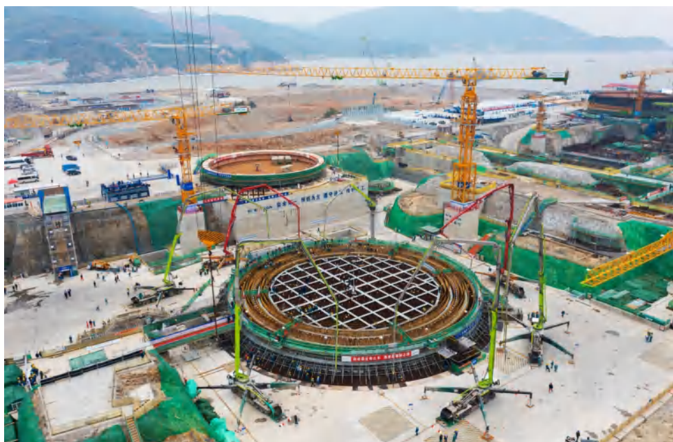
● 12月30日,三澳核电项目2号机组主体工程开工 (县重大能源中心 提供)
