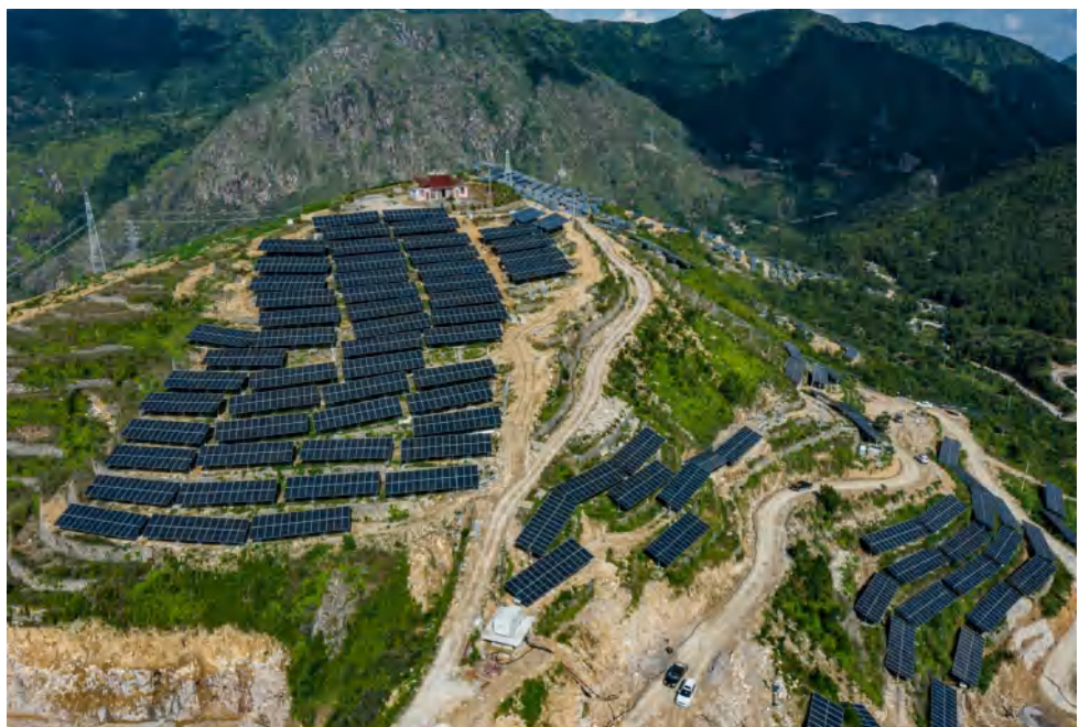
● 9月30日,藻溪赤溪光伏110千伏送出工程投产 (县供电局 提供)
