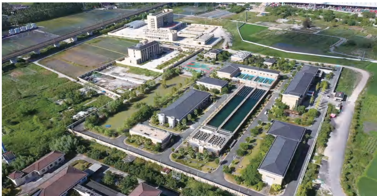
苍南县自来水有限公司新城水厂
