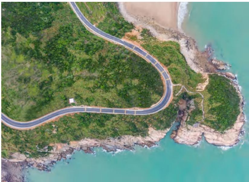
5月17日,168黄金海岸线(环海公路)三澳至瑶洞段“四好农村路”公路通车试运营 (方光迎 摄)
