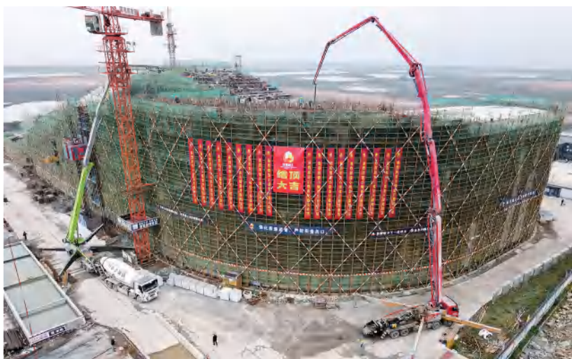
4月28日,绿能小镇第一个公建项目城市客厅顺利结顶
