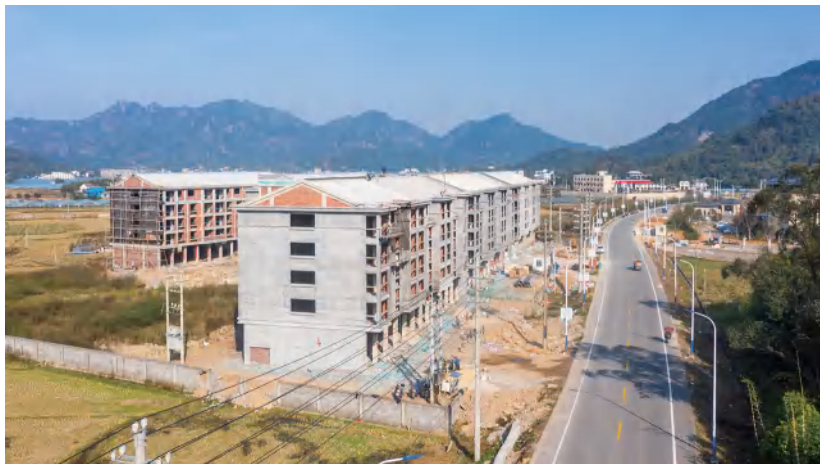
藻溪镇异地搬迁项目
