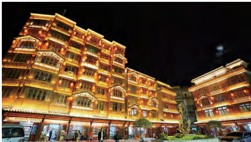
8月30日，霞关风情小镇老街改造提升工程项目竣工验收
