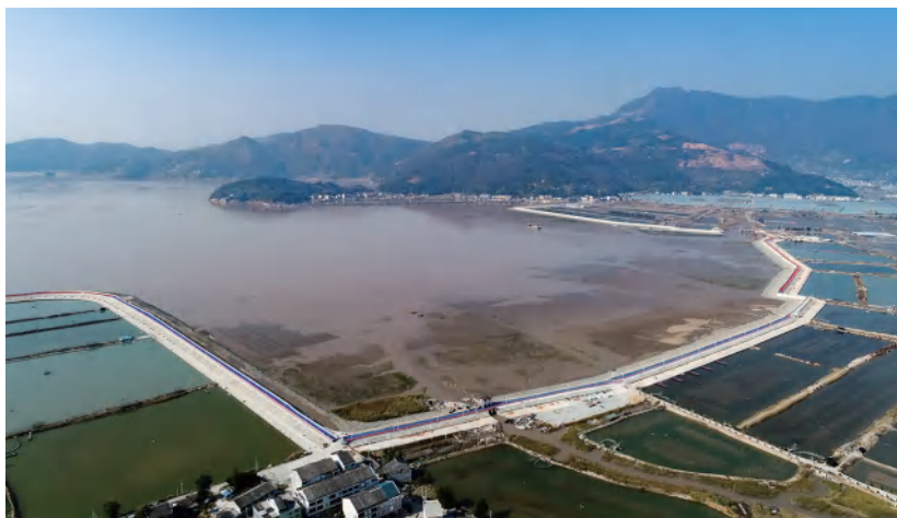
6月2日,苍南县沿浦海塘加固工程顺利通过竣工验收(县水利局 提供)
