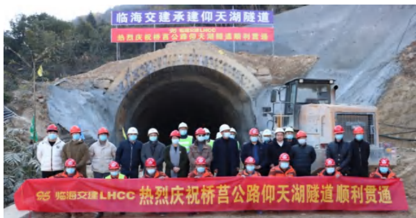
1月14日,苍南县桥莒公路提升工程仰天湖隧道正式贯通(高文潮 摄)
