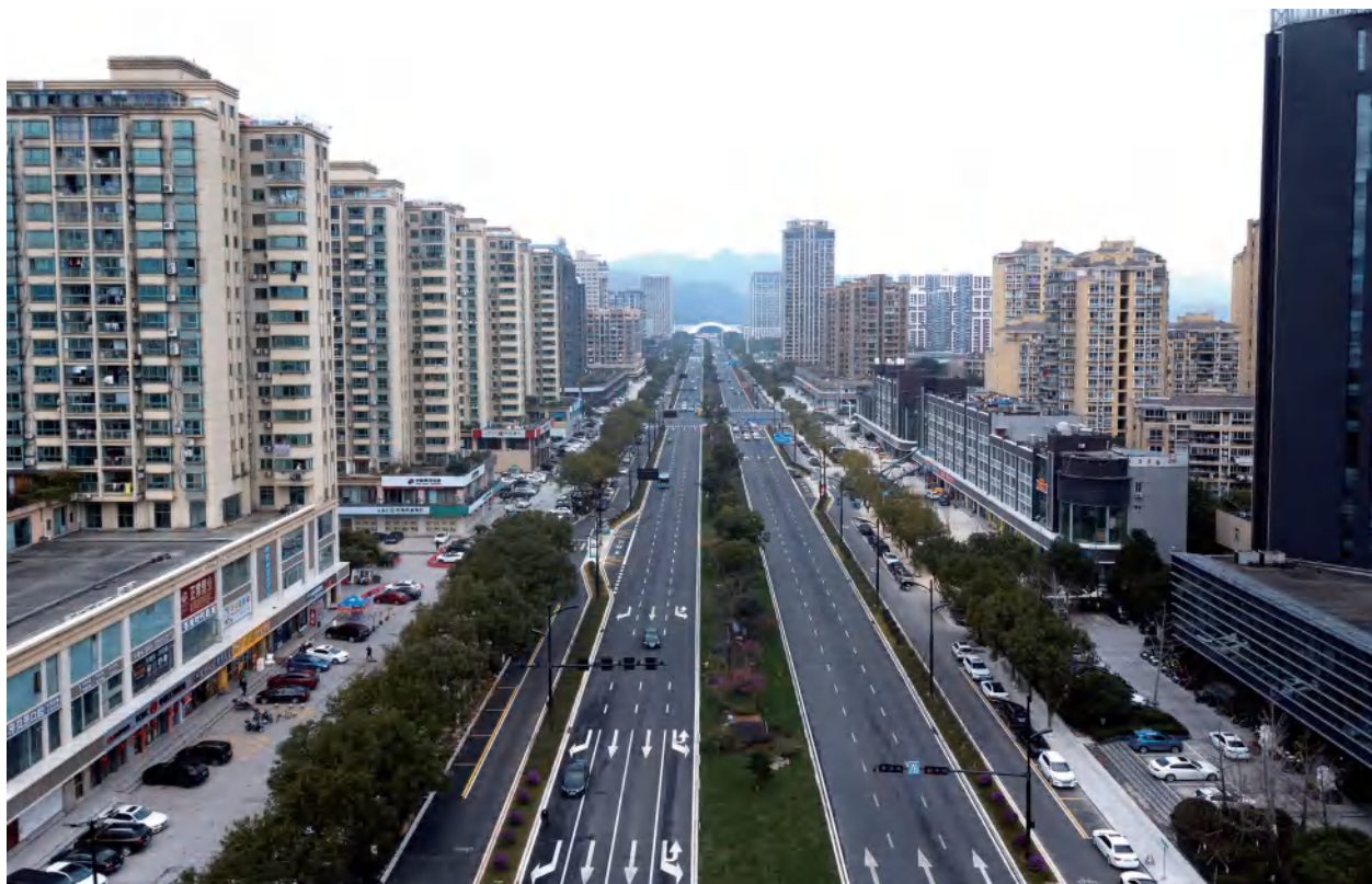
● 车站大道完成改造提升
