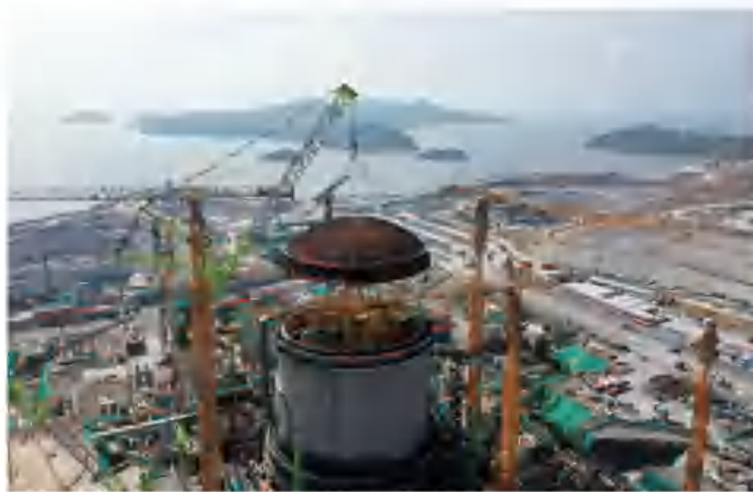
2023年9月28日,浙江三澳核电项目一期工程2号机组顺利实现穹顶吊装 (县重大能源项目建设管理中心 供图)
