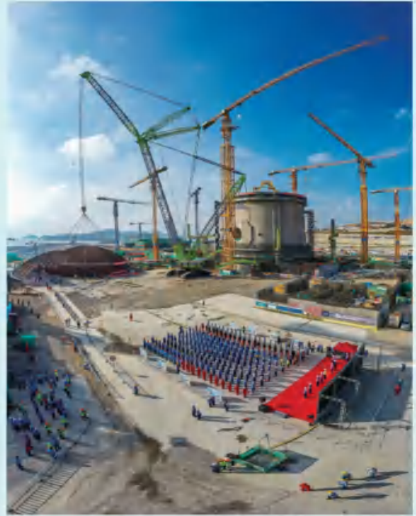
• 2023年9月28日,浙江三澳核电2号机组穹顶吊装 (县重大能源项目建设管理中心 供图)
