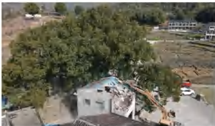
2023年3月8日,南宋镇拆除“苍南树王”下违建房屋
