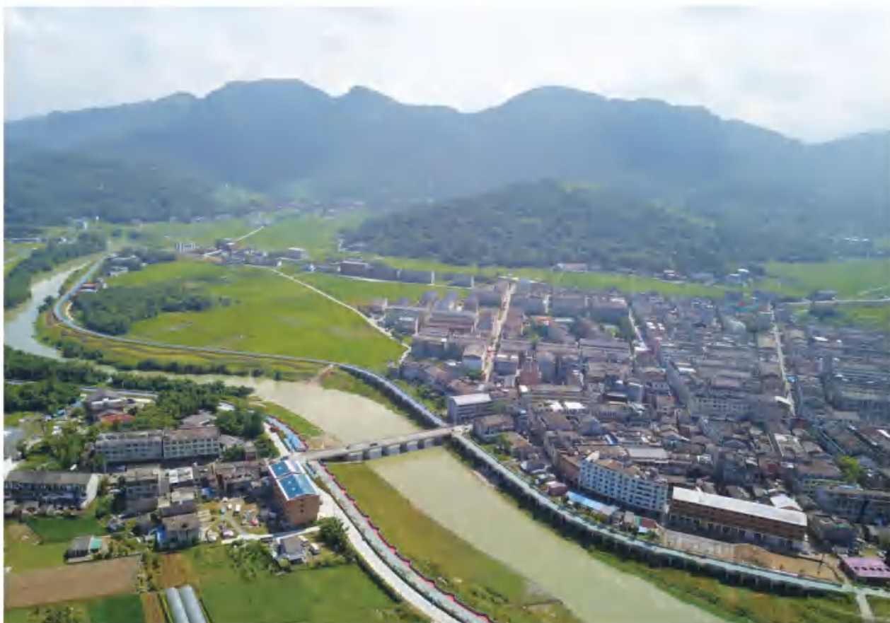
横阳支江堤防加固工程
