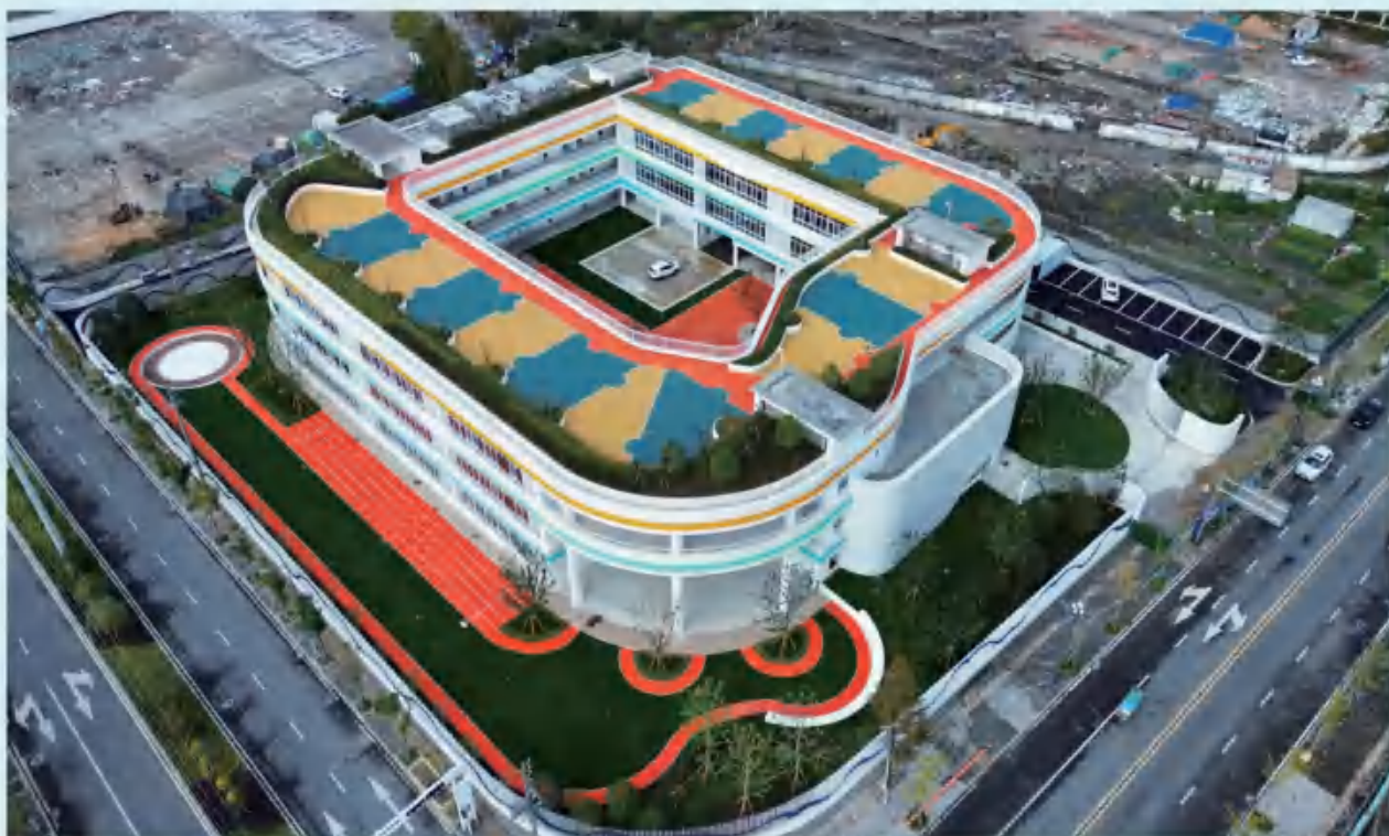
● 2023年11月,苍南县城新区实验幼儿园土建工程通过竣工验收
