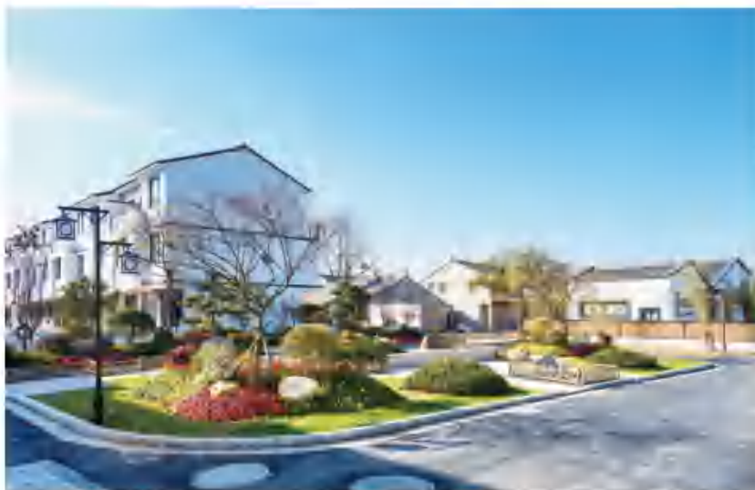
钱库镇来谊村、沿浦镇下在村、马站镇雾城村获评2023年度浙南民居样板村。图为钱库镇来谊村 (县住房和城乡建设局 供图)
