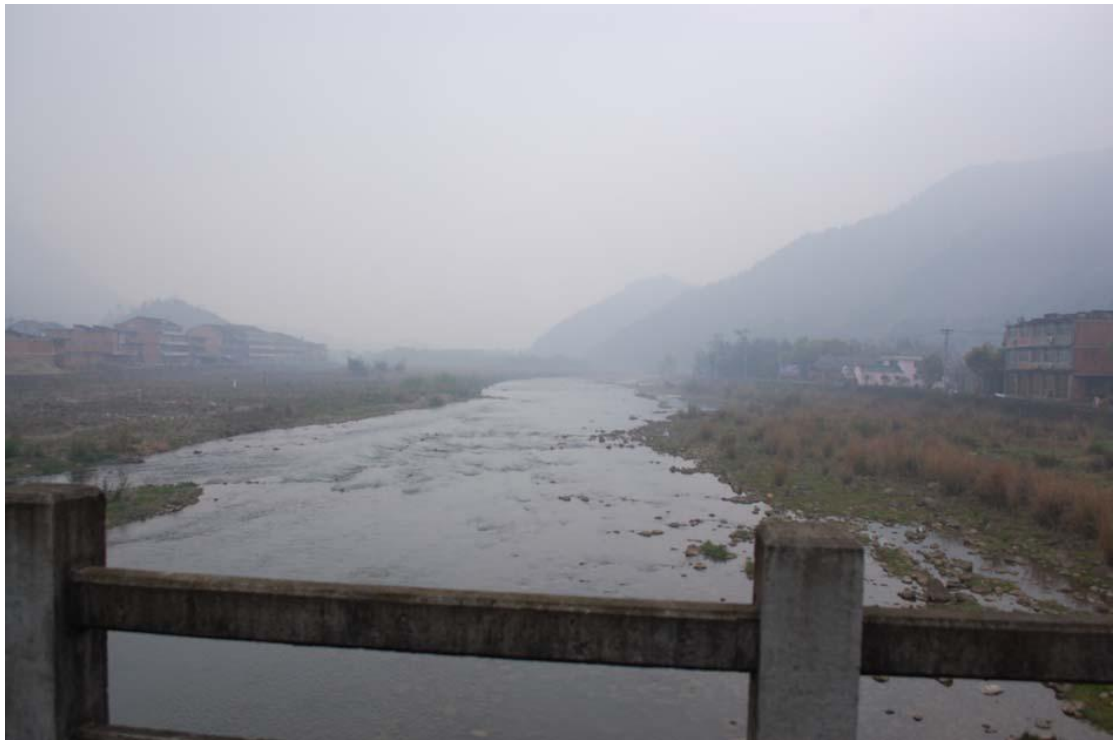
图 5.2.2-4 五十丈闸坝及上游库区现状图
