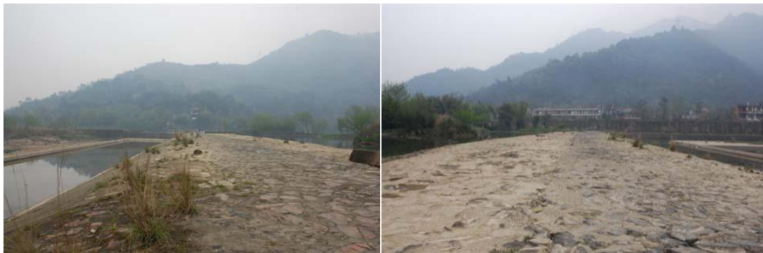
图 5.2.2-2 蒲潭垟闸坝现状图
