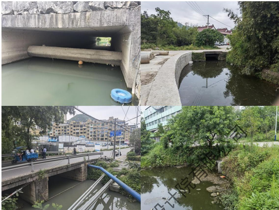
图 1.8-1 河道沿线阻水结构图
