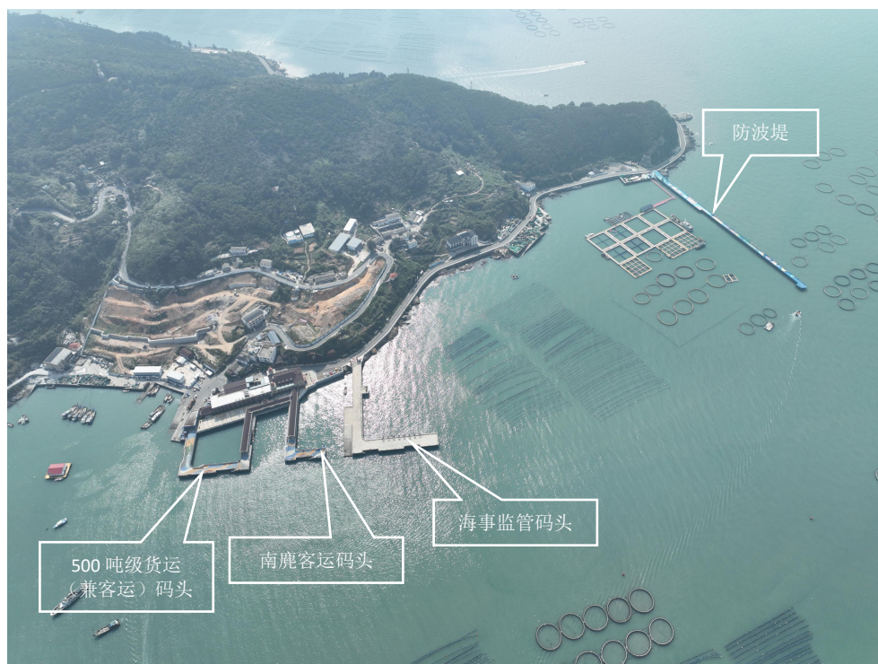
图 4.1.2-2 南麂岛码头、防波堤现状
