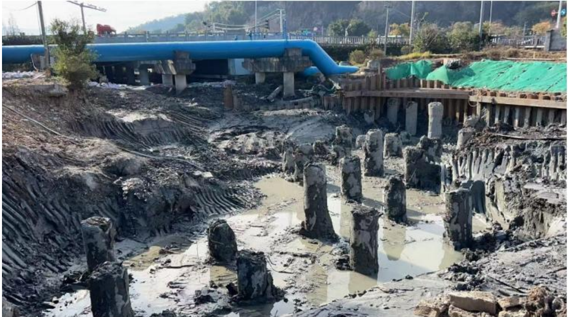
图 2-8 赤塘河节制闸施工面貌图
