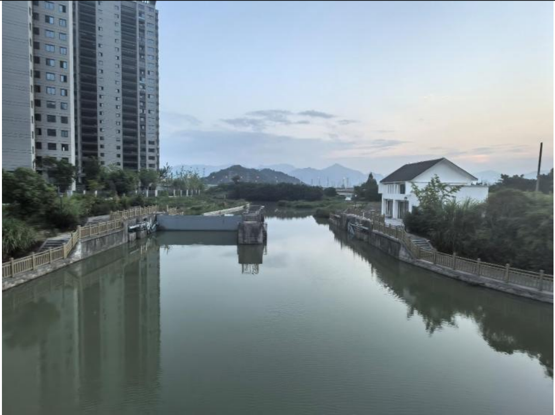
图 2-7 十八湾节制闸现状面貌图
