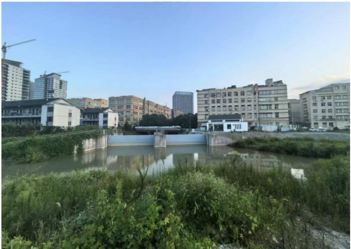
图 2-6 横塘河节制闸现状面貌图
