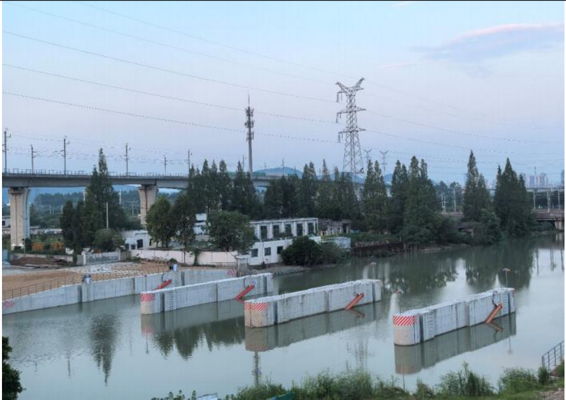
图 2-5 仙门河节制闸现状面貌图
