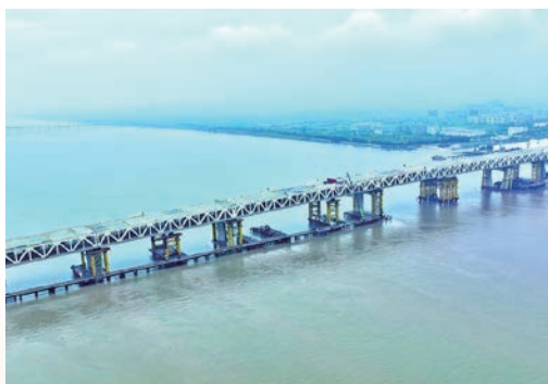
8月28日，国内最大跨度的公轨两用多塔刚性悬索桥——瑞安永宁大桥顺利合龙，为S3线项目建成通车奠定坚实基础 (张森/摄)
