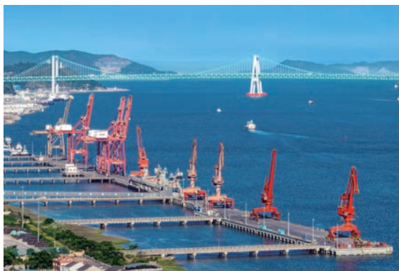
乐清湾港区码头风貌
