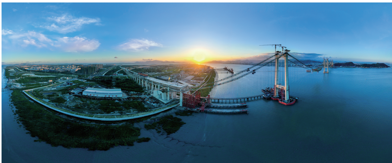
1 1 2 3 1. 在建浙江高度最高、跨度最大的山区斜拉桥——高岭头大桥 (刘春景 摄) 2. 杭温高速铁路一隧道施工现场 (陈智勇 摄) 3. 在建瓯江口北口大桥 (管新民 摄)
