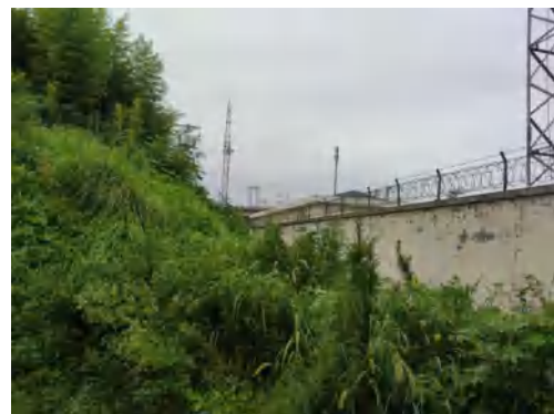
萧山 2#变电所北侧
