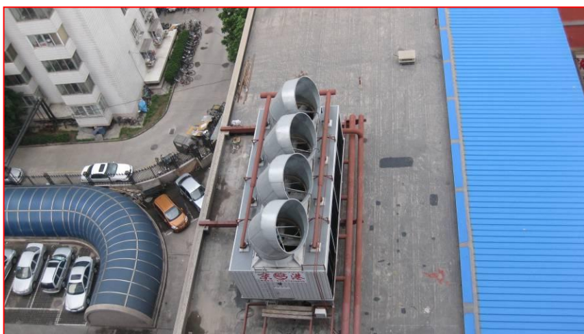
图 4.5-1 冷却塔导向消声器实施实例
