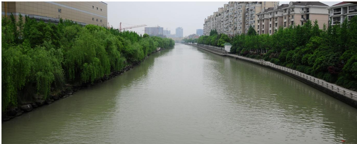
工程下穿京杭大运河余杭塘河段现状
