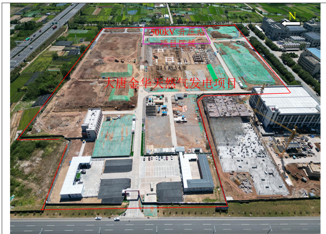
图 4.1 大唐金华天然气发电项目及 500kV 升压站工程周围概况
