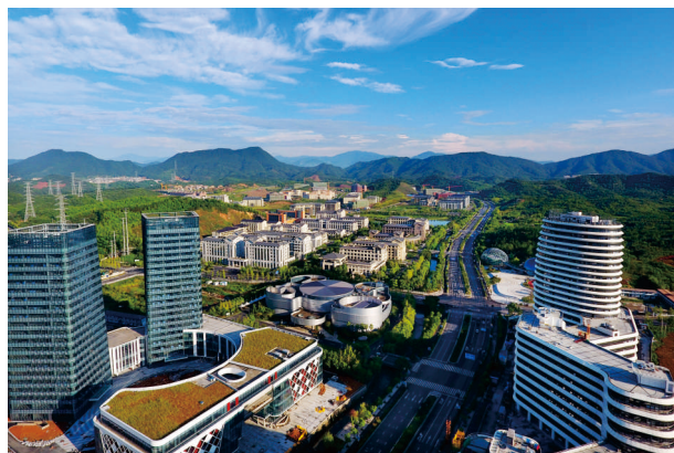
位于城西科创大走廊的青山湖科技城
