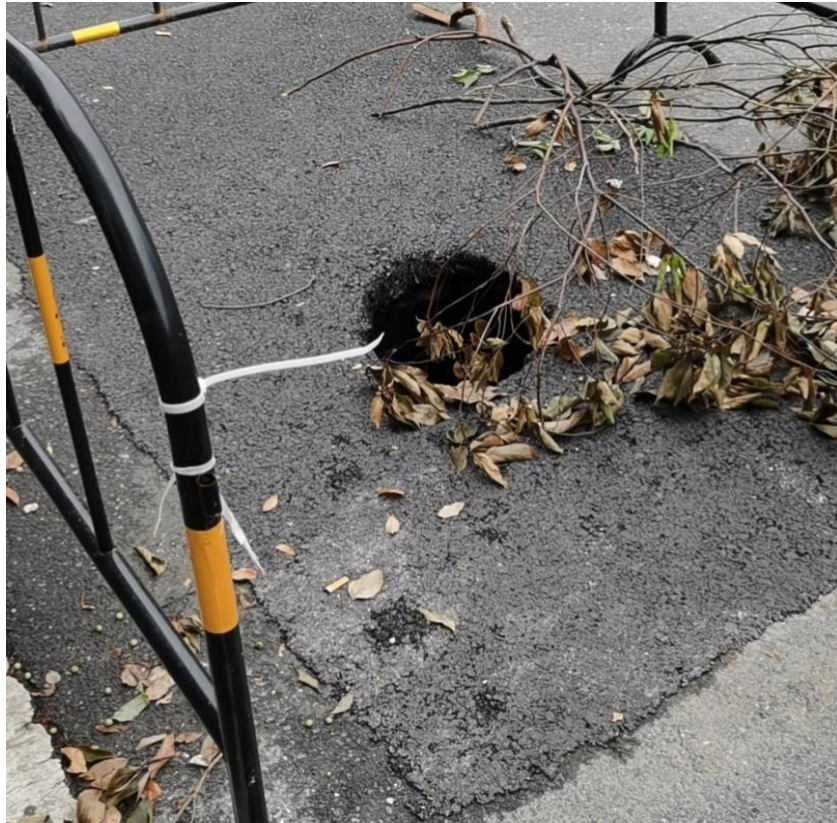
图 K.0.7 验证探孔施工场景图
