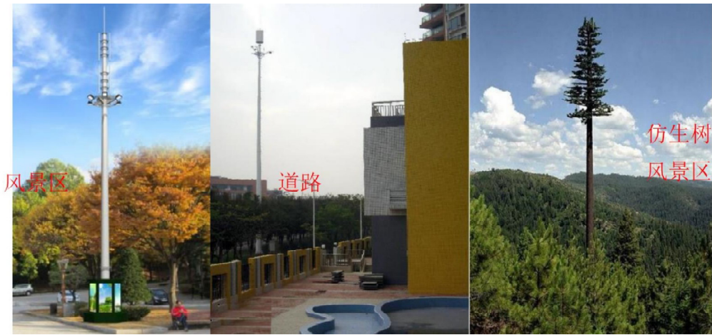
图 8-3 风景区及道路建设 5G 基站示意图
