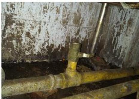
**7.燃气管道覆盖油污：清除油污，涂刷黄油，防止管道腐蚀、防止油污燃烧。**
