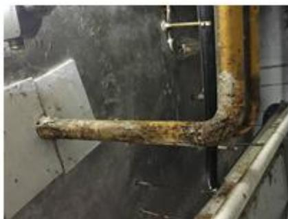
**6.管道末端用气设备拆掉后未封堵：确认阀门关闭，加装堵头。**
