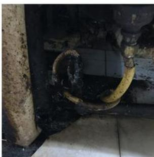
**8.其他隐患：（1）地下室、半地下室或地上密闭房间内的用气设备应有熄火保护装置，应设置独立的机械送排风系统，通风量满足国家规范要求；（2）燃气设施禁止包封，应设置通风口；（3）燃气管道设施及周围禁止堆放杂物、腐蚀品、易燃易爆品。**
