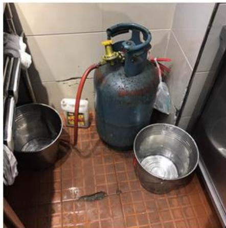
**3.软管超长、无管卡固定、有接口等隐患：改用燃气不锈钢波纹管连接灶具，并选用合适的管径。**
