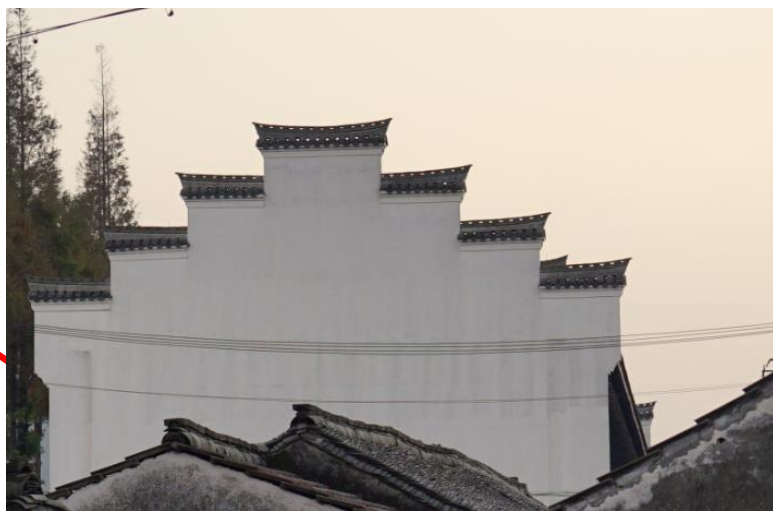
慈溪某古镇新建马头墙采用元宝砖做筑脊压顶
