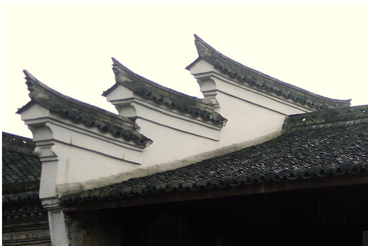
象山儒雅洋何恭房马头墙修缮后
