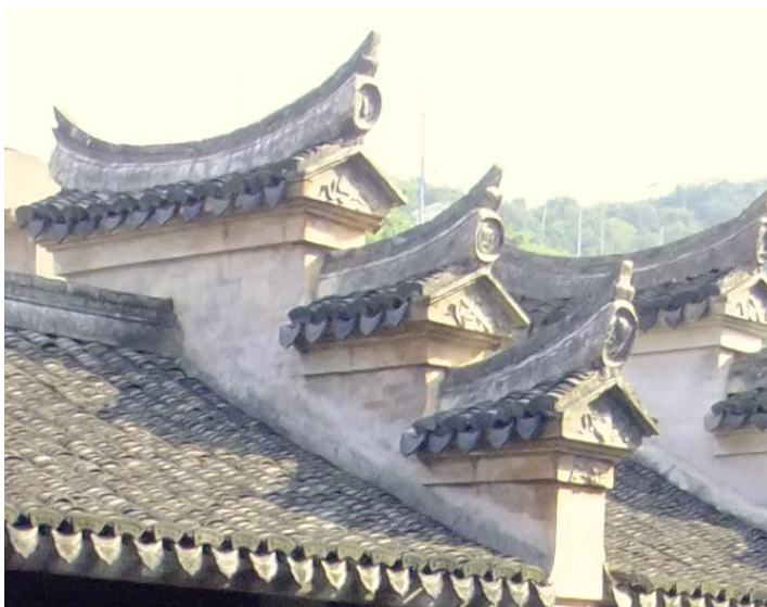
象山 石浦老街马头墙维修后，马头墙用滴水瓦，筑脊抹灰过度。
