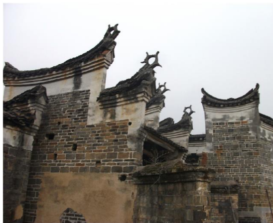
图 2-7 赣派建筑中挺拔憨实的马头墙 (图片来自网络)
