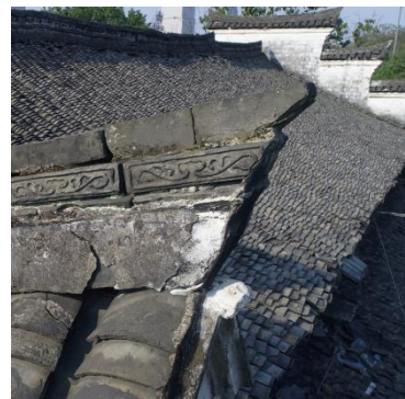
图2-17 筑脊斜劈砖戗头
