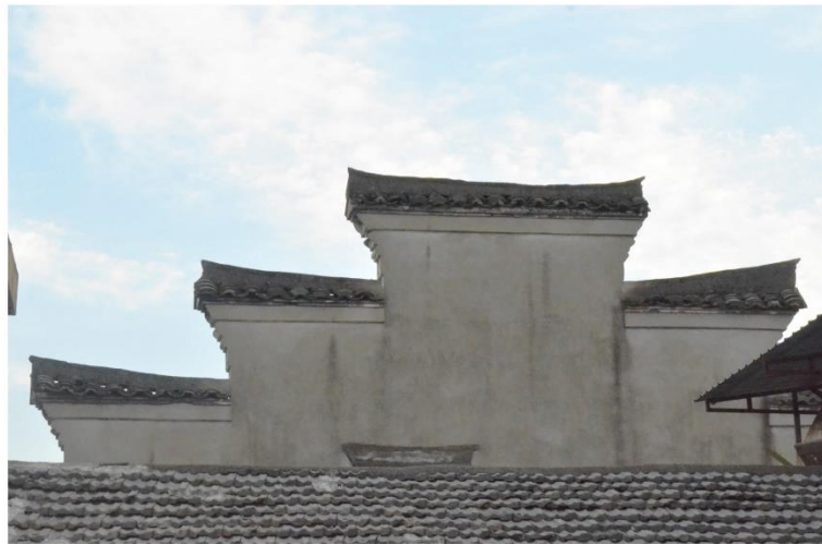
图 3-24 毛洋村毛洋大屋马头墙正面
