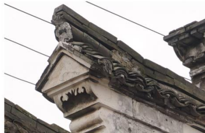
图 3-7 慈城后新房冯宅山墙脊端，筒瓦滚筒
