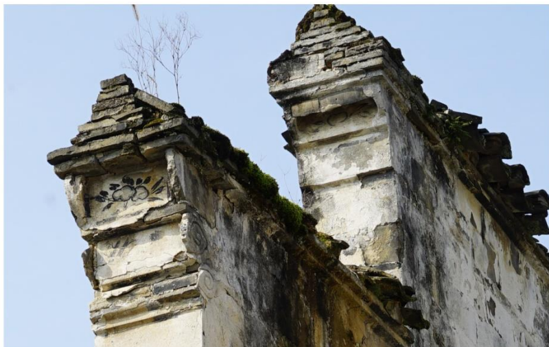
图 2-18 奉化岩头村马头墙构造局部 砖砌变坡
