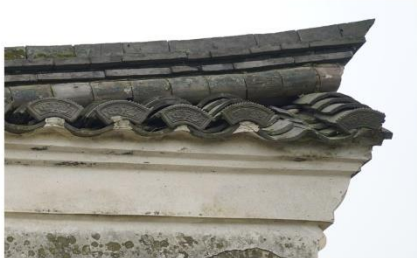
图 3-3 江北庄桥马径乾坤房山墙脊端，筒瓦滚筒
