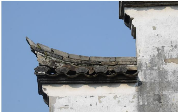
图 3-40 岩头村马头墙局部图
