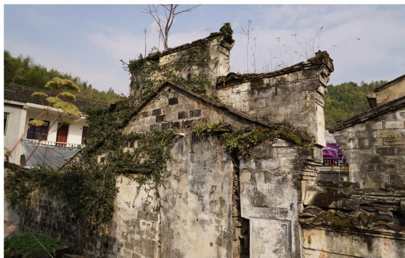
图 2-20 奉化岩头村马头墙遗存
