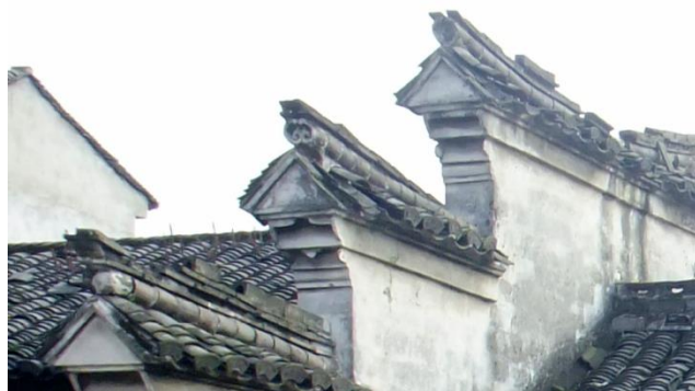
图2-13 筒瓦滚筒马头墙
