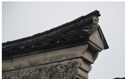
图 3-5 江北庄桥马径茂昌房山墙脊端，筒瓦滚筒
