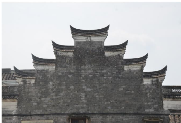
图 3-28 走马塘老宅马头墙正立面
