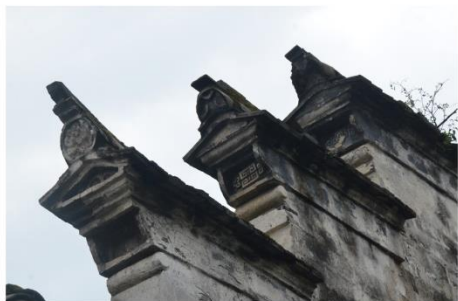
图 3-50 宁海黄坛镇益善堂马头墙端部收头类似甬式马头墙，有刻花。
