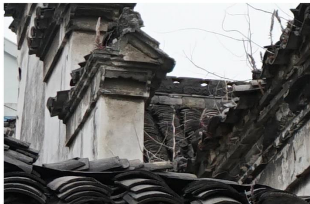
图 3-61 余姚府前路某宅马头墙局部
