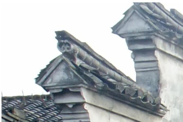
图 3-21 镇海团桥寺后胡大夫第山墙筑脊，筒瓦滚筒，端面如意纹
