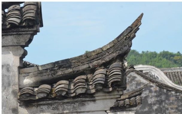
图 3-39 马头村马头墙局部图
