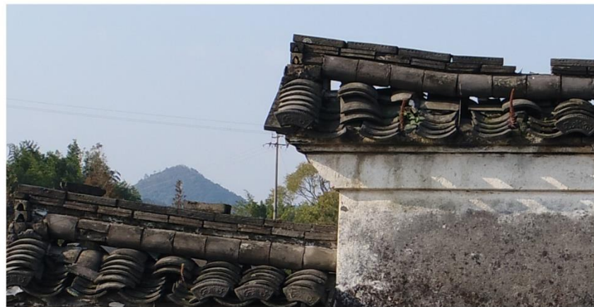
图 3-14 慈溪鸣鹤五房大屋山墙筑脊龙骨砖叠砌，粉碑状座头
