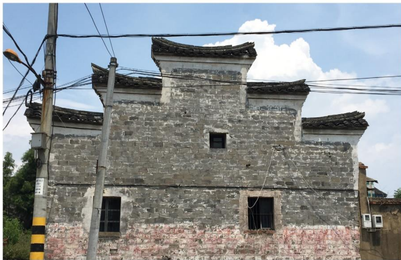
图 3-22 鄞州姜山镇走马塘老宅马头墙正面
