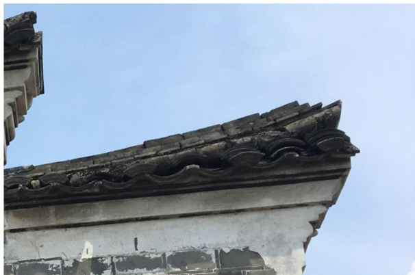
图 3-23 鄞州姜山镇走马塘老宅马头墙局部
