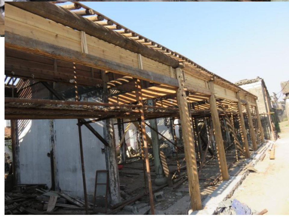
正厅后排柱梁局部落架大修
