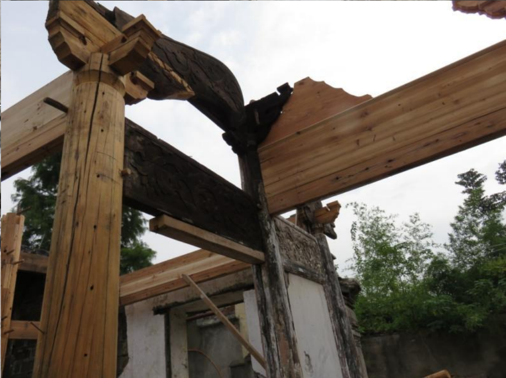
门厅修缮过程
