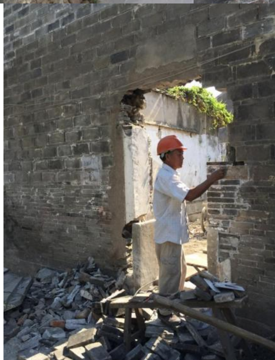
墙体局部修补
