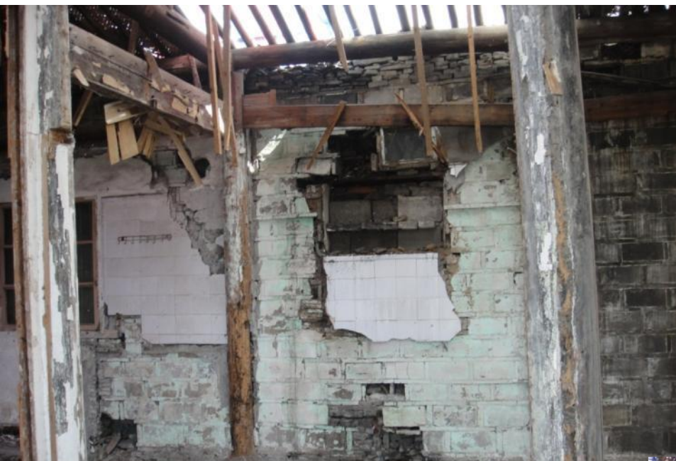
正厅（局部落架，拉正）
