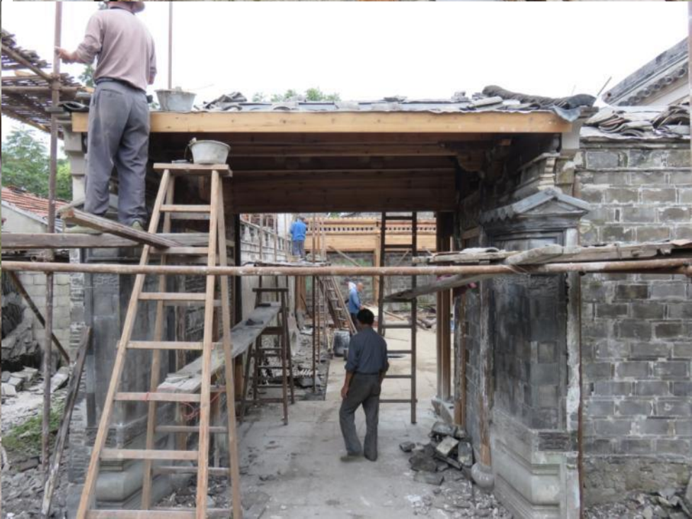
门厅修缮过程
