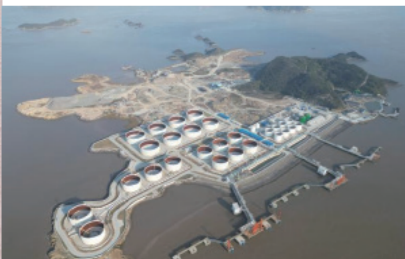
■ 东白莲岛油品储运基地
