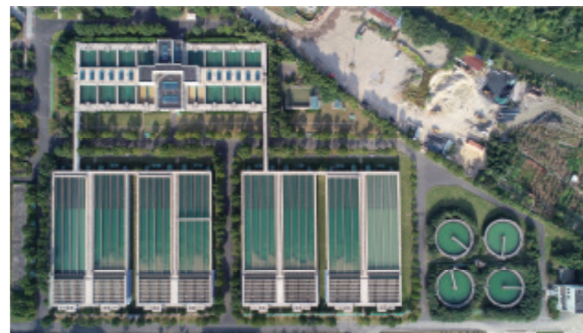
■ 宁波工业供水公司（工业水厂）俯瞰图
