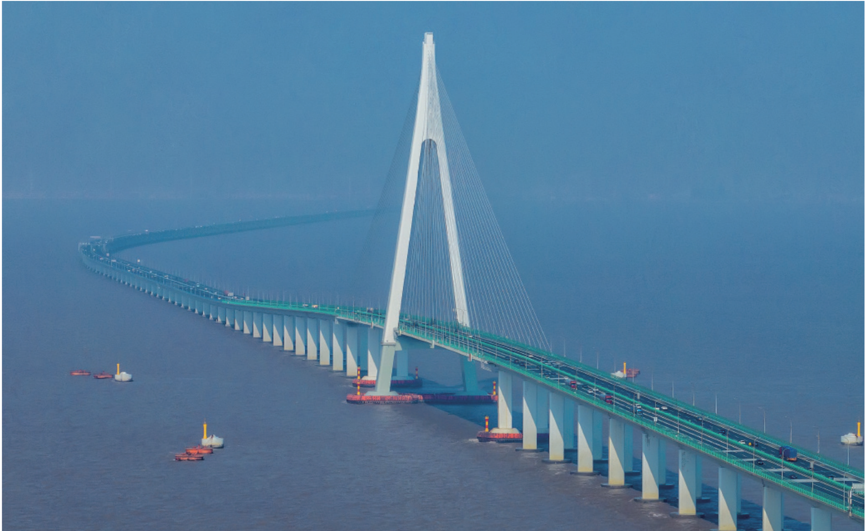
■ 杭州湾跨海大桥
