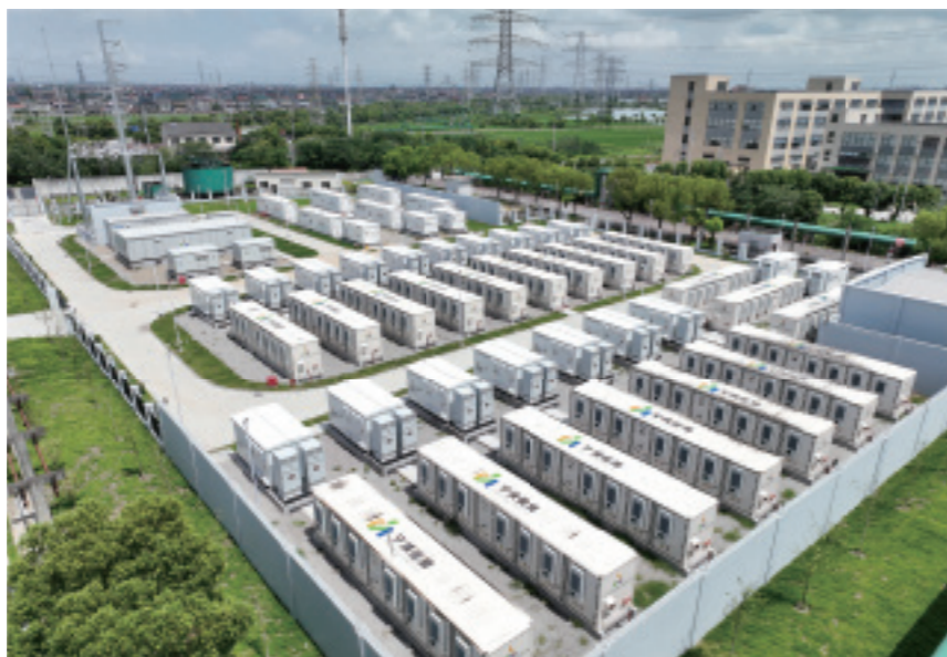
■ 宁波朗辰新能源有限公司50MW/100MWh独立储能电站项目
