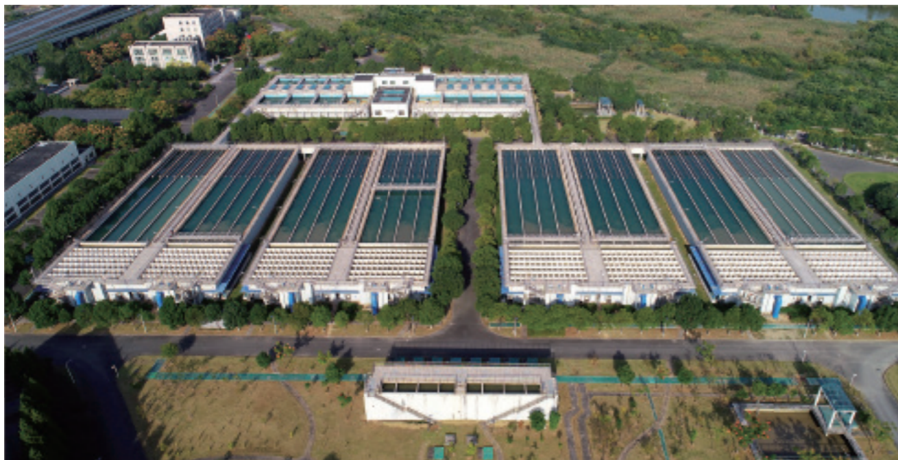
■ 宁波工业供水公司（工业水厂）俯瞰图
