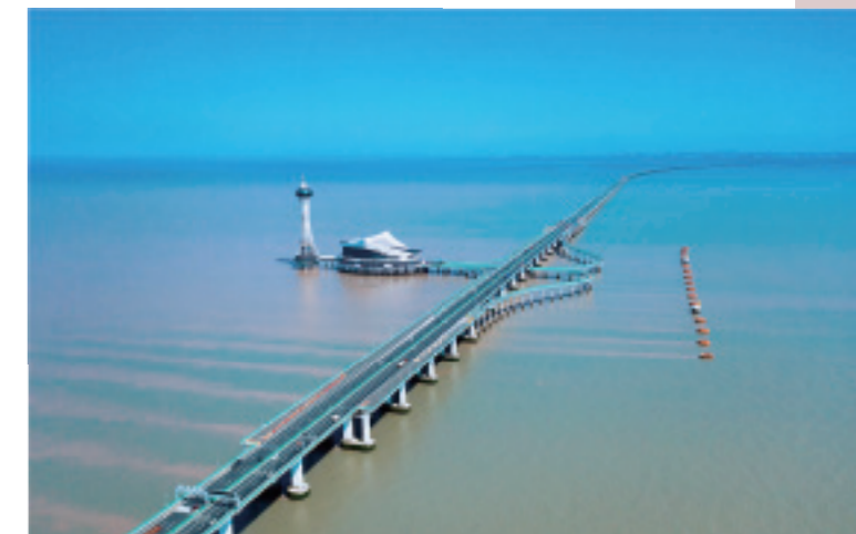
■ 杭州湾跨海大桥
