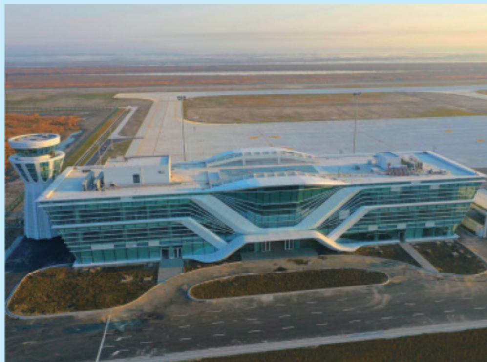
■ 宁波前湾新区通用机场项目一期航管综合服务楼
