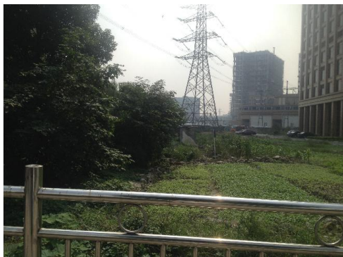
220kV 石南变北侧进线现状
