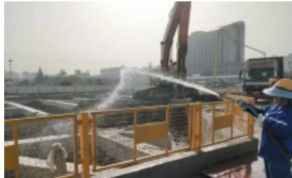
所有土方开挖、回填等施工环节必须洒水湿润;单个装卸点至少设置1个雾炮,装卸作业时必须全程开启。
