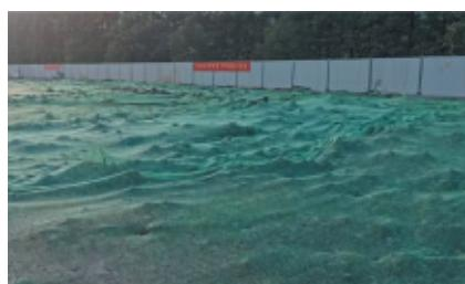
施工场地或管养范围内的裸土、砂石料等扬尘源需进行有效覆盖(裸土是指非施工作业的裸露土地或空置超过24小时的土方)。为防止造成扬尘污染,有条件的可以进行绿化,无条件的应采用土工布等材料进行有效覆盖。
