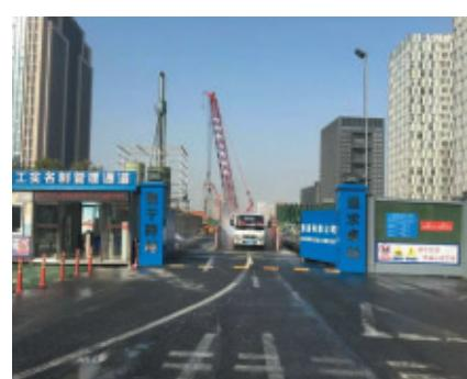
项目大门口必须设置自动冲洗装置和专职人工冲洗管理员，确保运输车辆车身、轮胎、底盘等部位积泥冲洗干净且密闭后方可出场，冲洗时间不少于2分钟。
