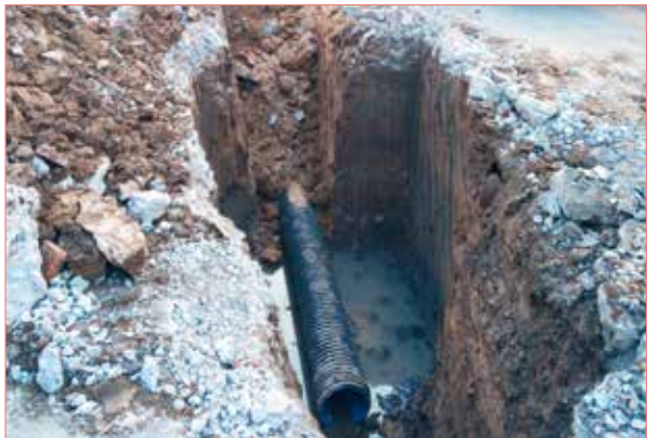
2014 年 10 月,西蜀阜村生活污水改造工程施工现场。 (华舍街道供稿)
