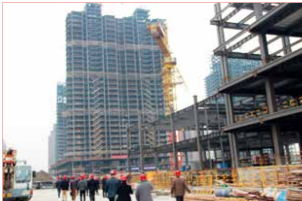
2014 年 12 月 19 日,柯桥区组织企业考察萧山钢结构产业。 (区建管局供稿)
