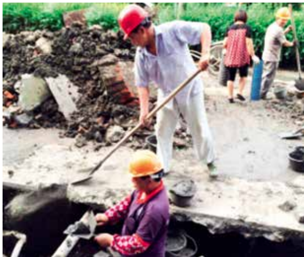
2014年,柯桥城区内涝防治(一期)工程施工现场。 (区建设局供稿)
