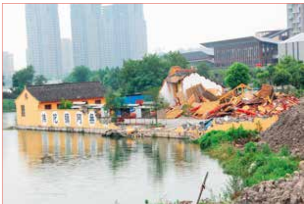
2014 年,柯桥街道一民间信仰场所拆除现场。 (徐 敏摄)
