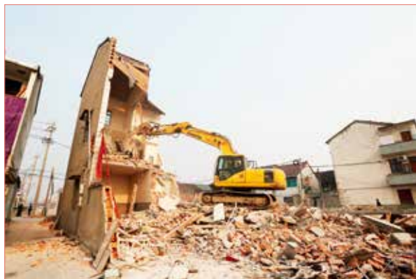
2014 年 12 月 9 日,大型挖掘机对湖塘街道柯湖路最后两处 500 余平方米拆迁遗留房屋进行拆除。 (湖塘街道供稿)
