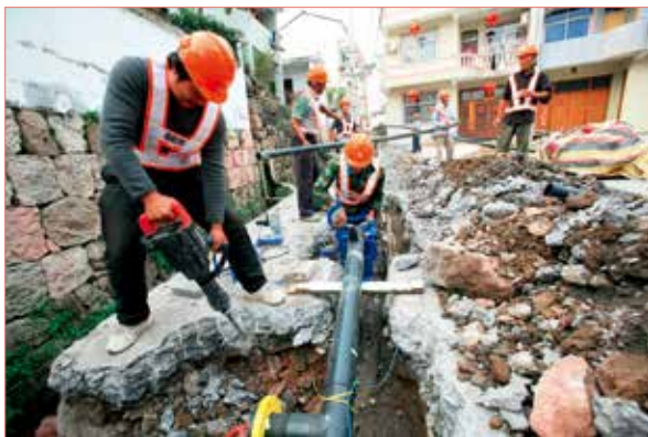
2014年10月,柯桥区水务工作人员对农村供水管网进行改造。 (区水务集团供稿)
