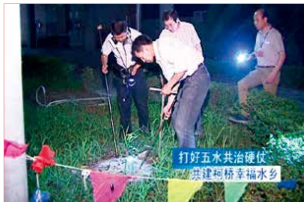
2014年6月25日,柯桥区机关事务管理局工作人员对区职教中心水管进行查渗听漏。(沈桔敏摄)
