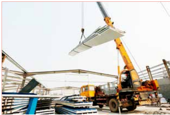
2014 年 12 月 8 日,鉴湖江沿线的船舶修理厂自行拆违。 (湖塘街道供稿)
