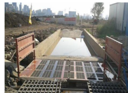
设置洗车槽实例图
