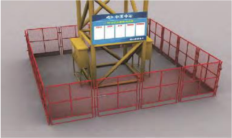
塔吊基础防护
