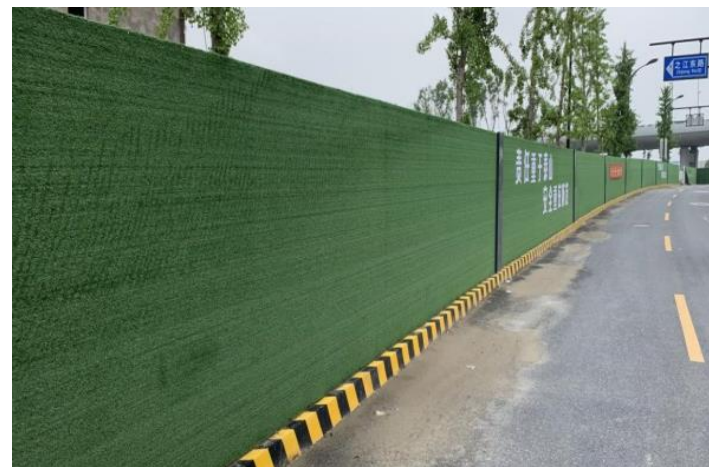
组合式彩（塑）钢板围挡实例图
