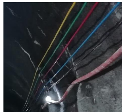
洞内电路敷设实例图
