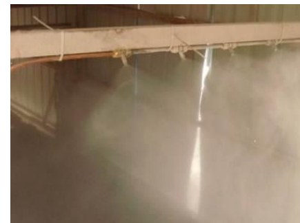
洒水降尘系统实例图
