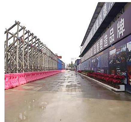
行车道场地硬化实例图
