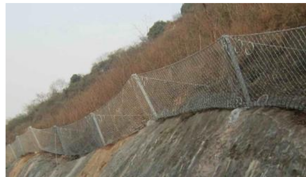
边坡防护网实例图
