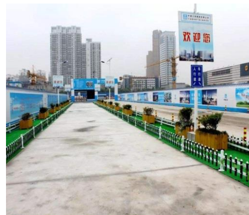
施工人员通道场地硬化实例图
