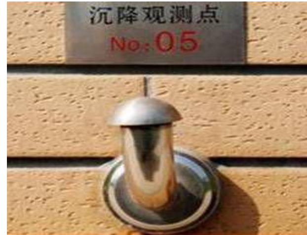
构筑物沉降监测实例图
