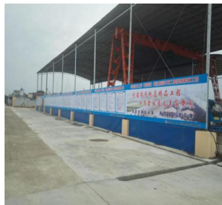
加工生产区场地硬化实例图
