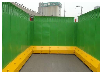
设置隔震防护罩实例图
