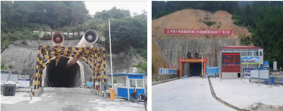
隧洞口防护实例图
