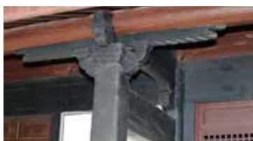
图五 都督第二进明间前檐柱上斗拱、雀替
