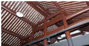
图二 都督第二进东次间穿斗式梁架结构
