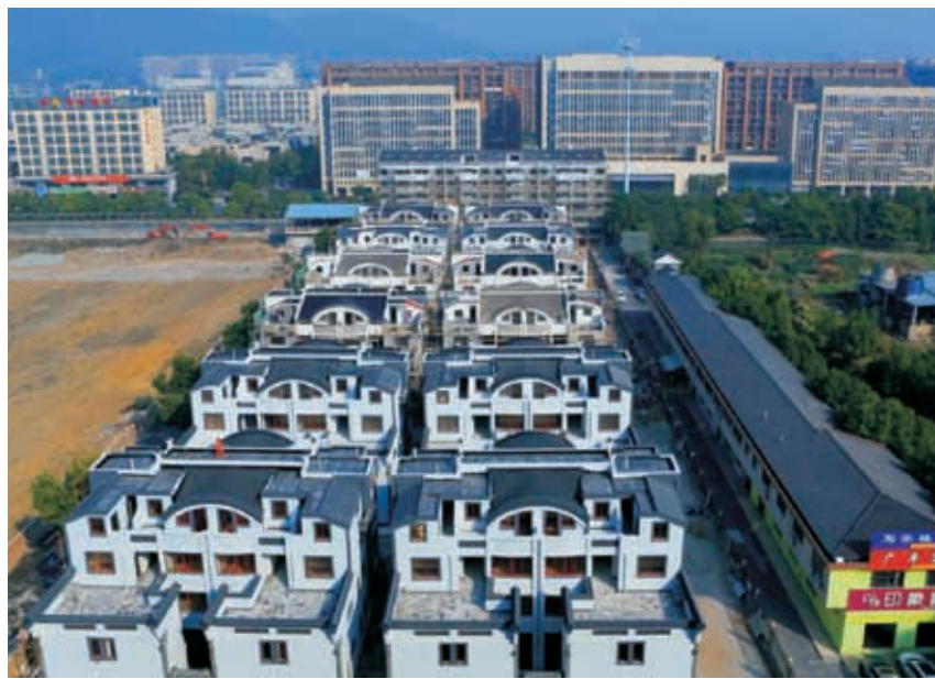
2018年10月31日,华丰悦居蓝领公寓改建项目完工
