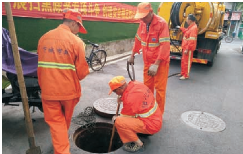
2018年10月16日,区市政公司下水道养护班组在泰和苑小区进行清淤作业
