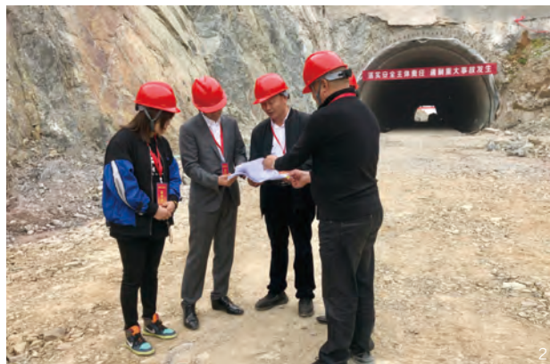
南岳镇人大监督小组在里一隧道施工现场视察建设情况
