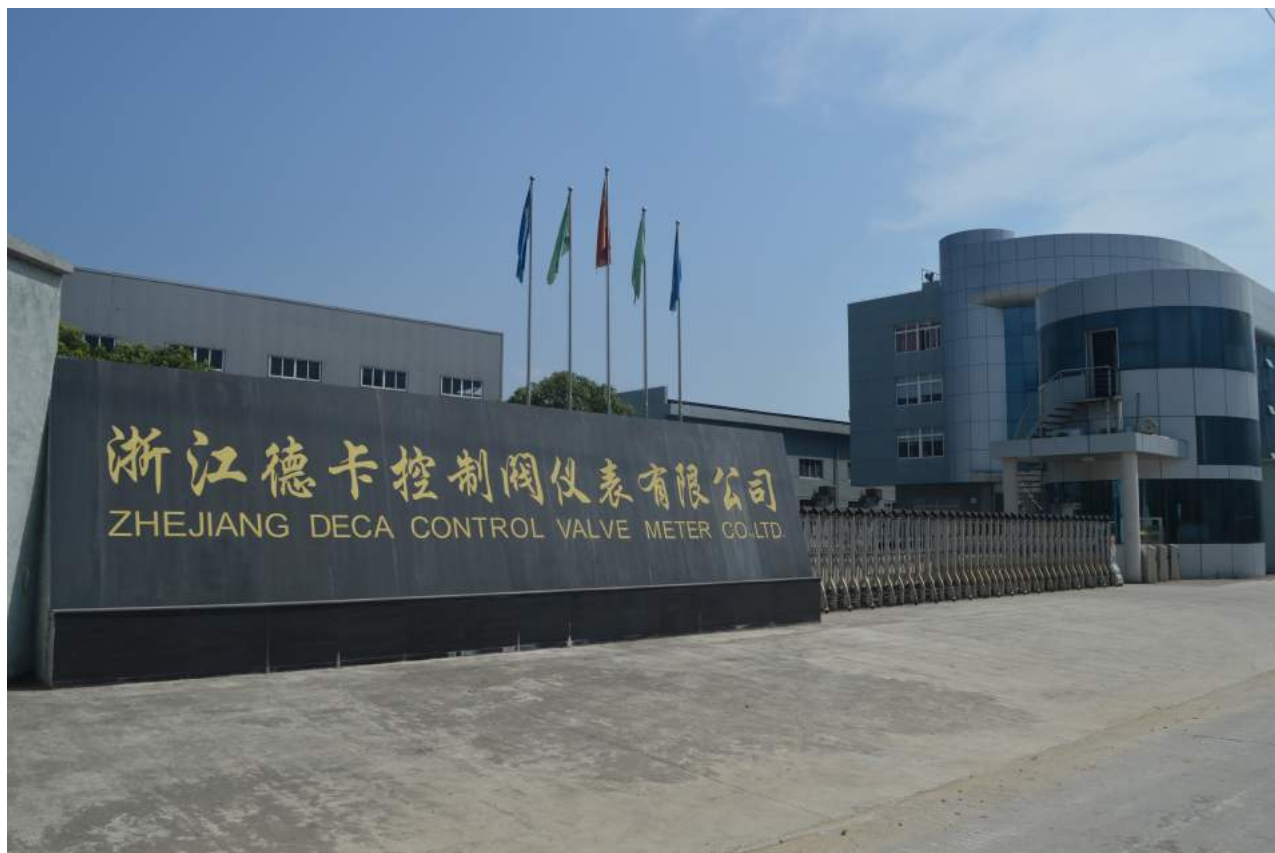
2015年5月份进驻巨屿工业园区
