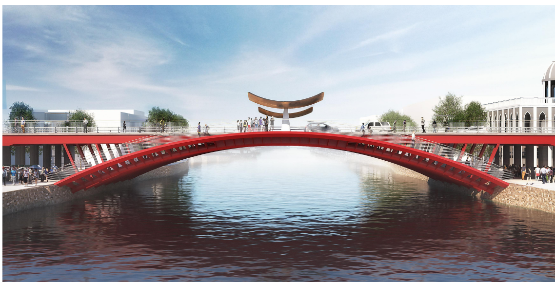
图 1-5 钢管混凝土拱桥效果示意图
