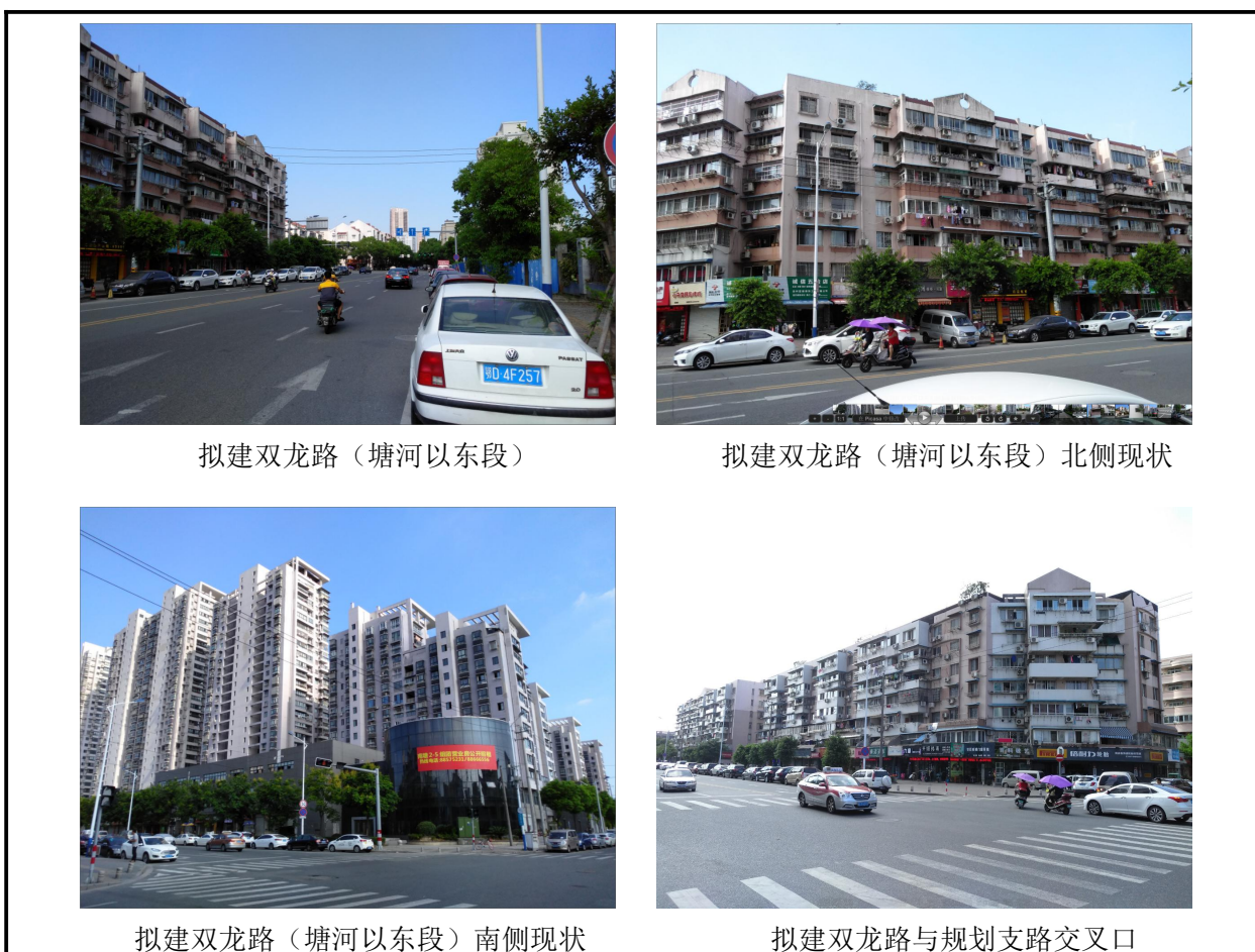
图 3-3 本项目拟建道路沿线现状
