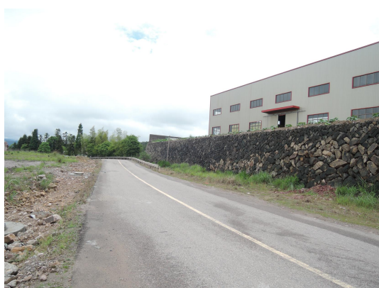
东侧：工业区道路
