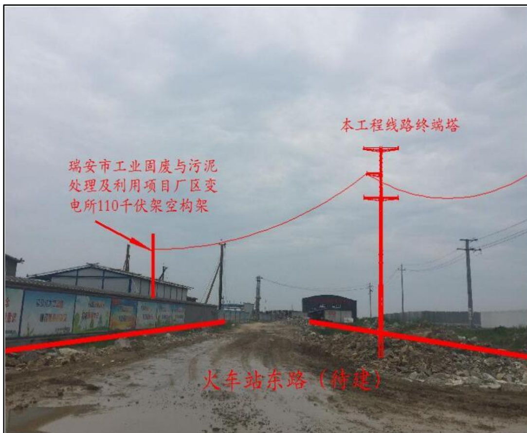
图 1.4 大有热电厂区出线示意图
