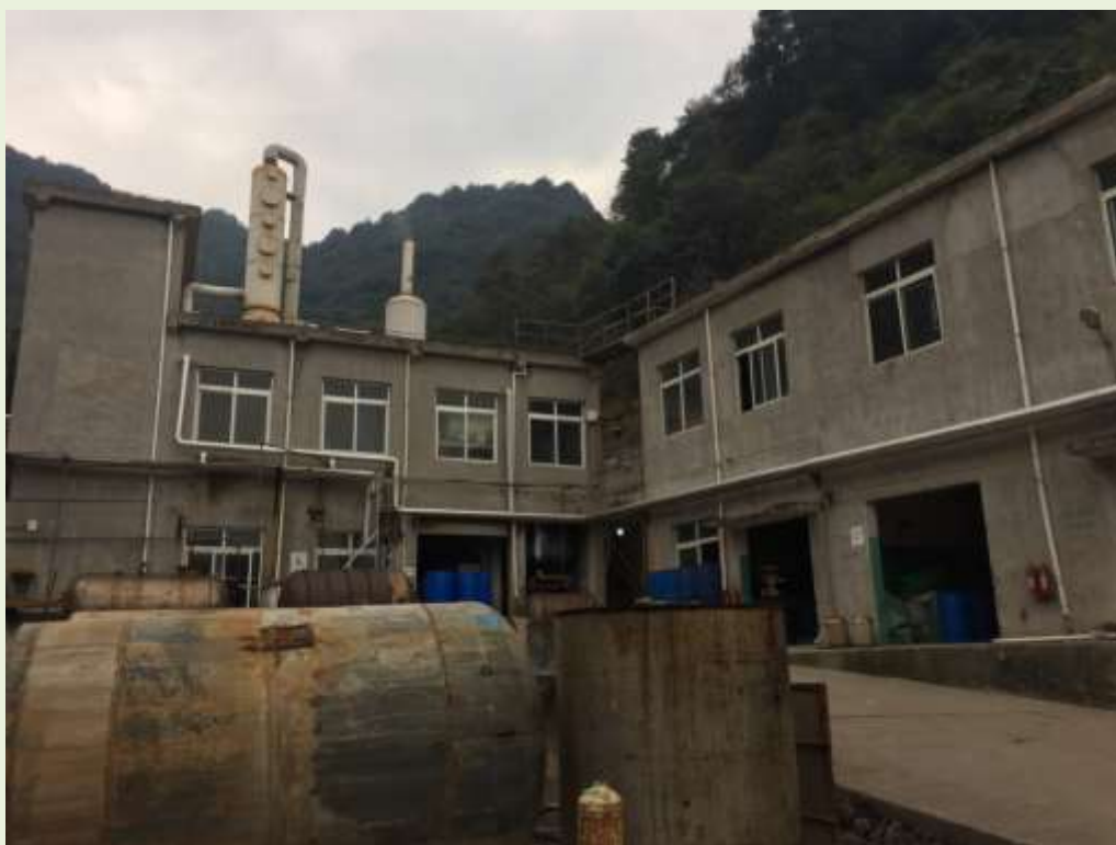
图 3.8-2 活性炭吸附塔
