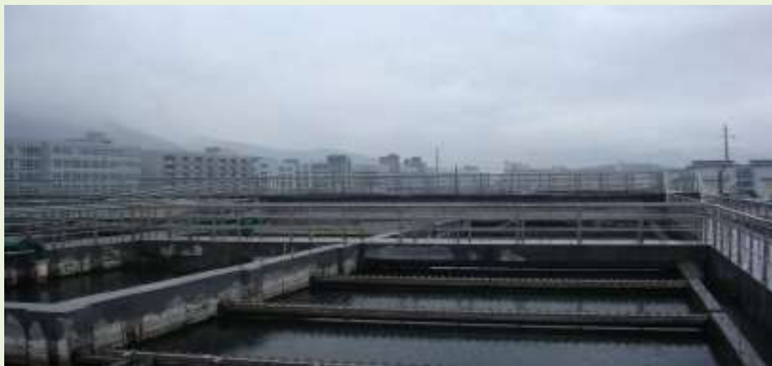
图 5.2-1 依托污水处理设施照片
