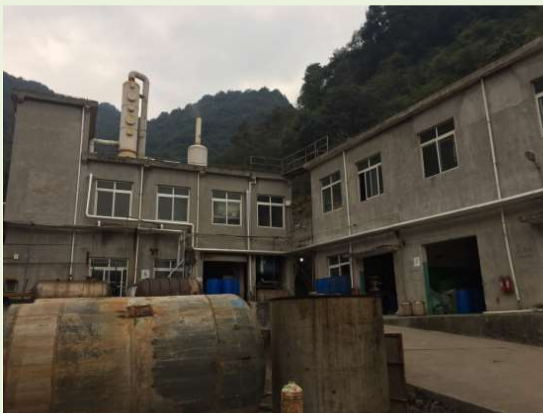
图 7.2-2 活性炭吸附塔
