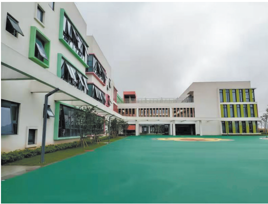
海城实验幼儿园建设工程。
