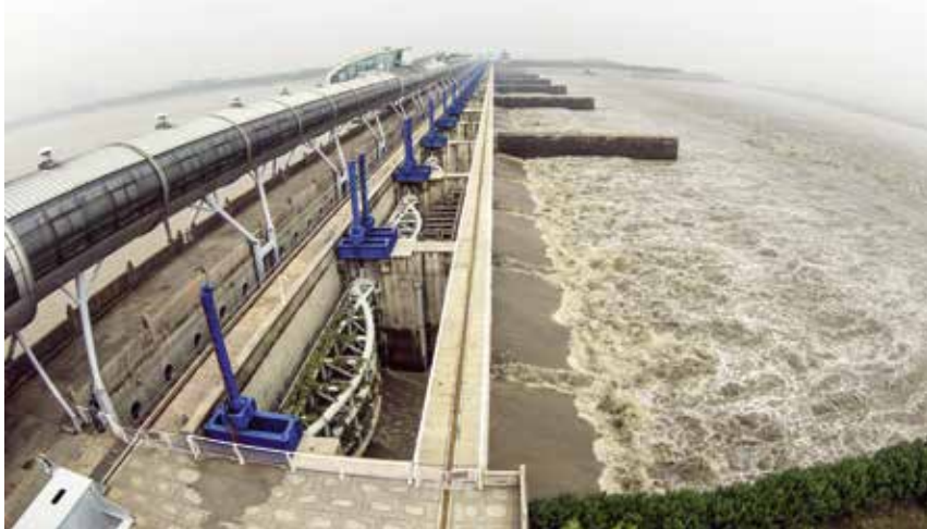
2020年汛期,曹娥江大坝全力泄洪
