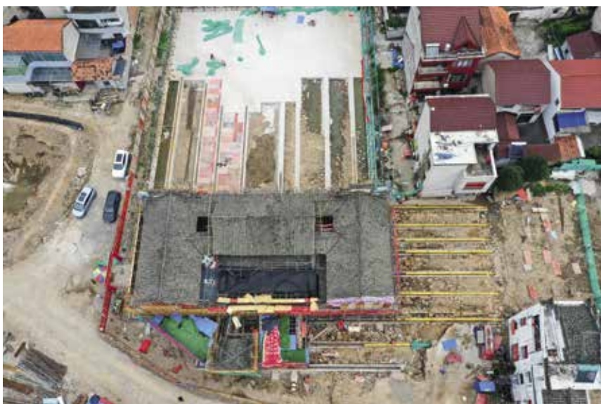
2020年7月21日,嵊州苍岩基成台门实施无感整体平移 (嵊州市文物保护中心 提供)
