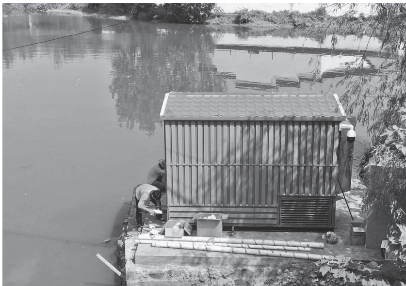
工人建设水质自动站
