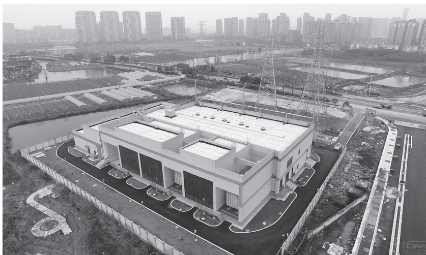
6月，220千伏东浦变电站工程投入运行（王乾鹏摄）
