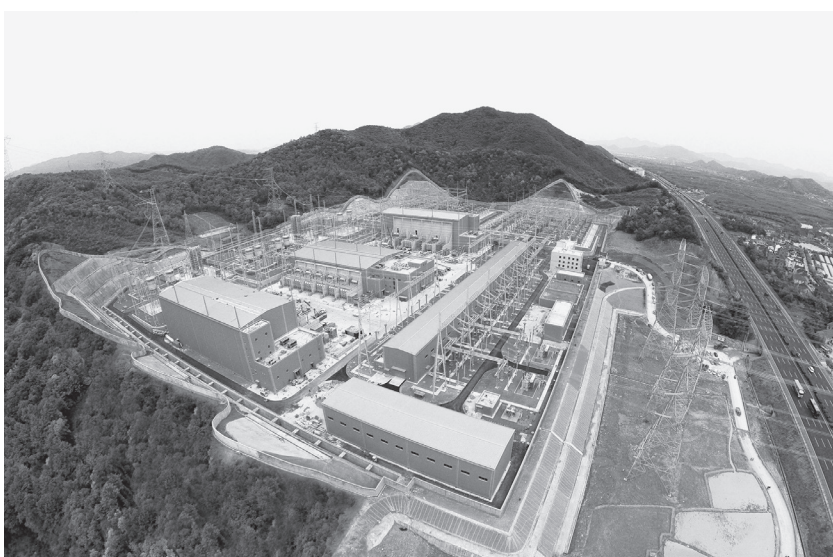
8月24日,灵绍特高压绍兴换流站正式移交运行(王乾鹏摄)
