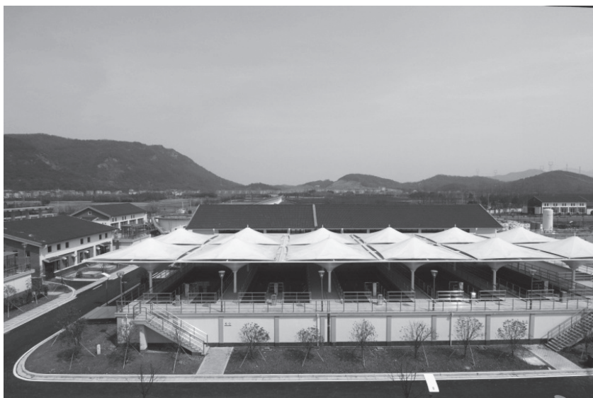
平水江水厂滤池
