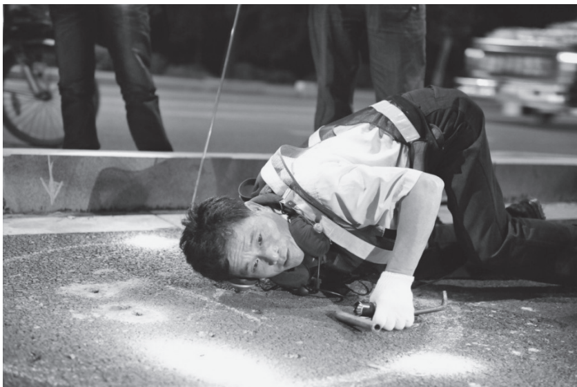
8月14日深夜,市水务集团职工检查水管有无渗漏
